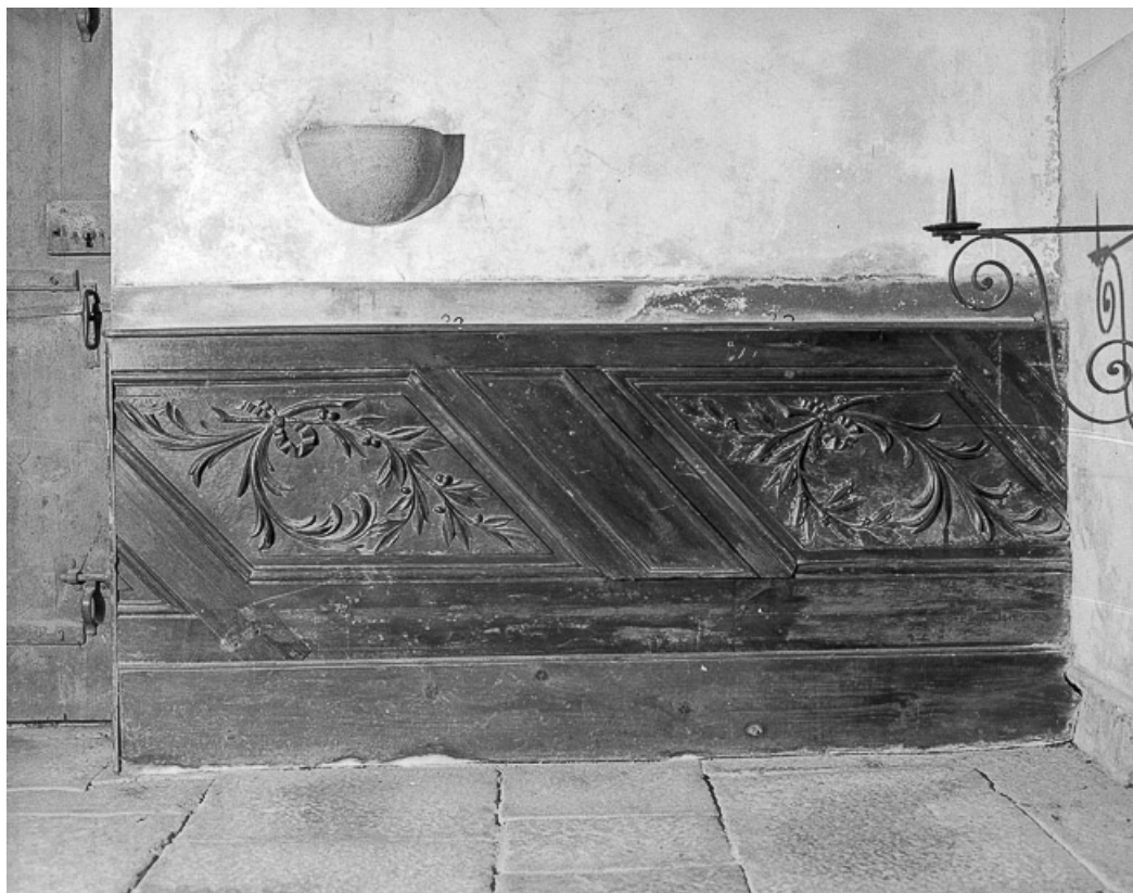
Détail : ancienne rampe utilisée en lambris.
