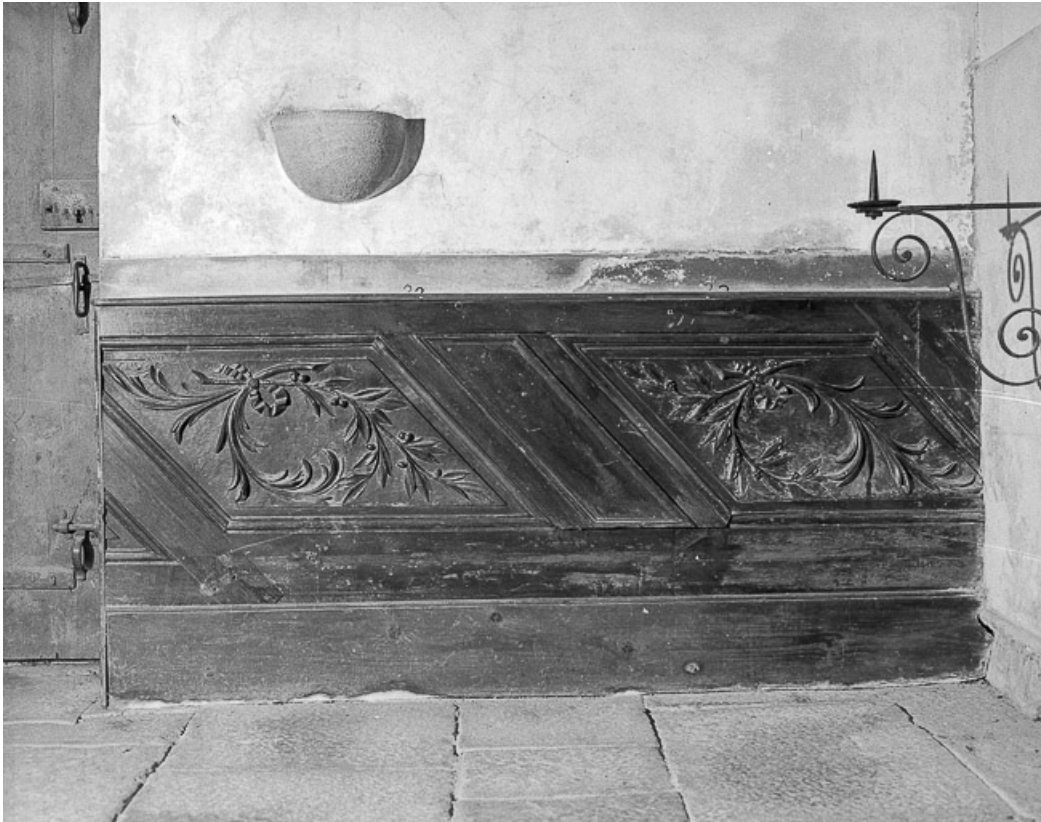
Détail : ancienne rampe utilisée en lambris.
