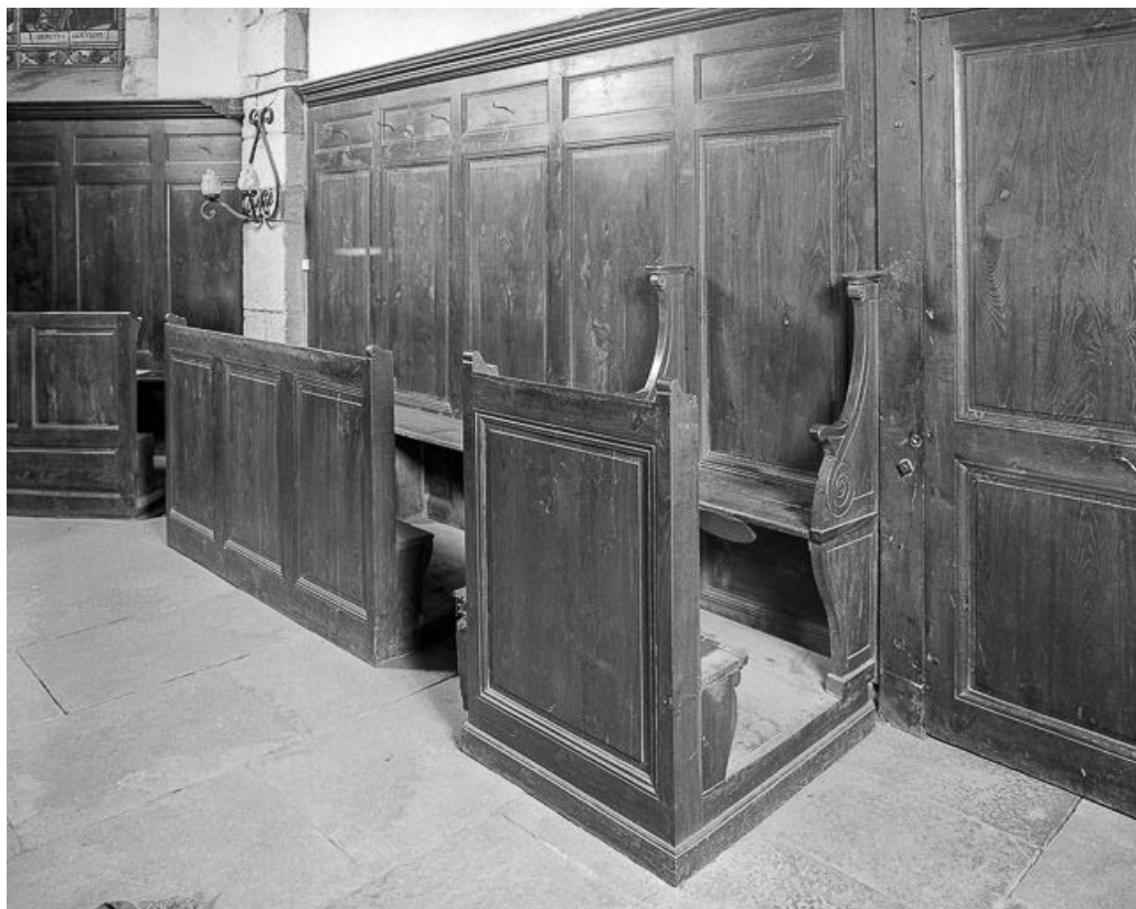
Vue de la partie droite des lambris et fausses stalles du choeur.
