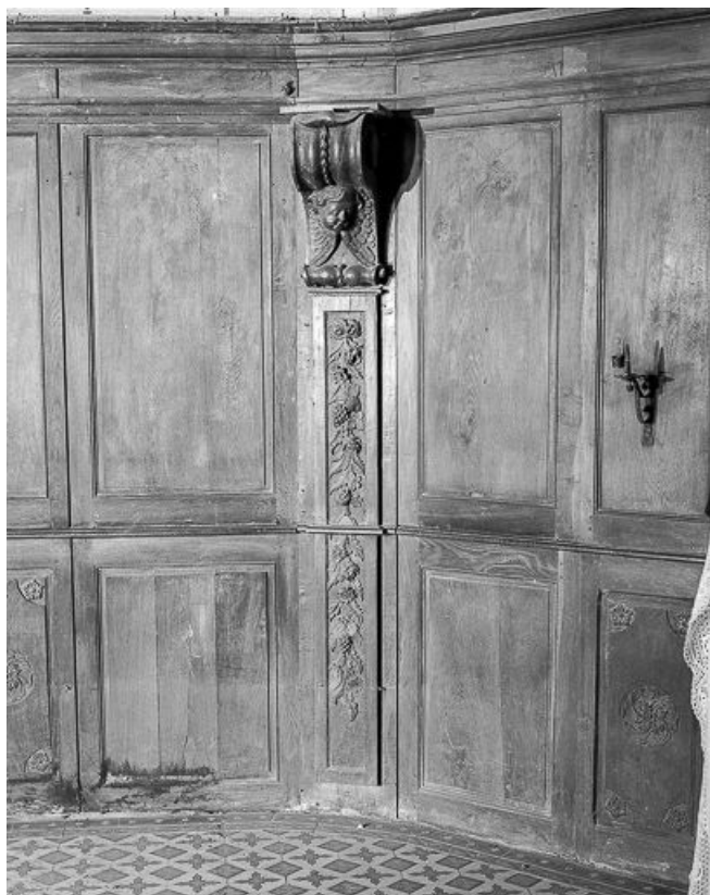
Détail : pilastre et console, premier angle de l'abside.
