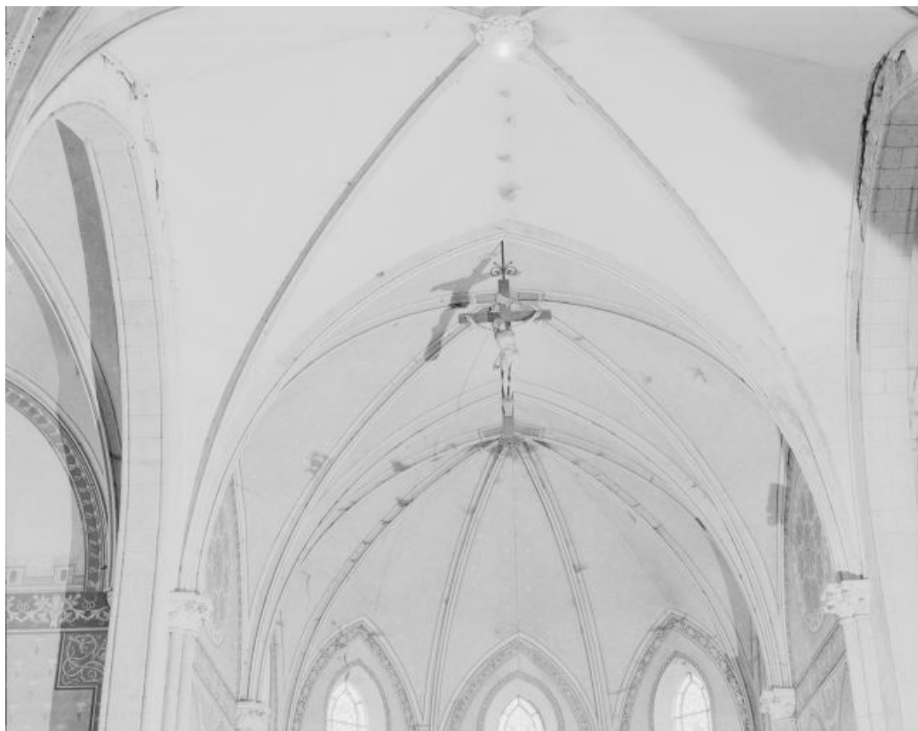
Vue générale en contre-plongée.
