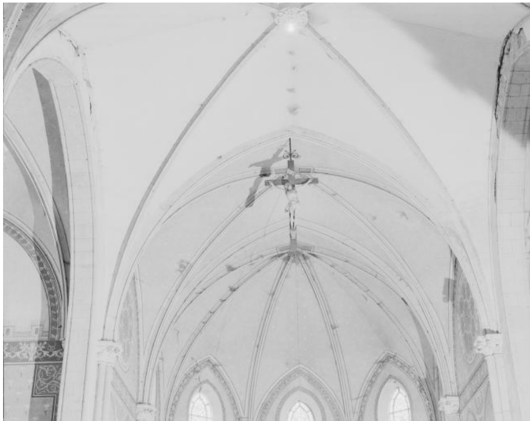
Vue générale en contre-plongée.
