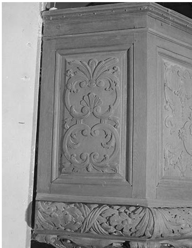
Cuve : premier panneau.
