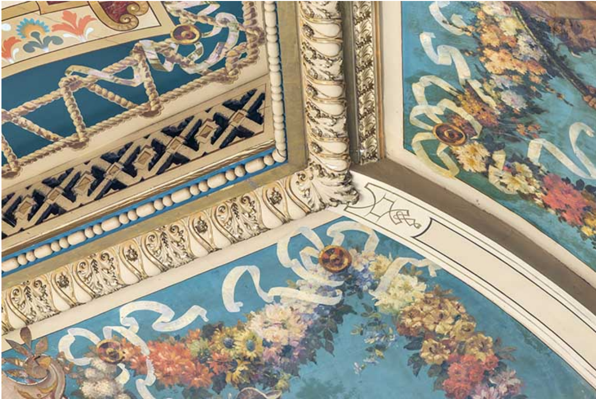
Grand Kursaal, salle : moulures au niveau de la fausse-coupole. 25, Besançon, 2 place du Théâtre
