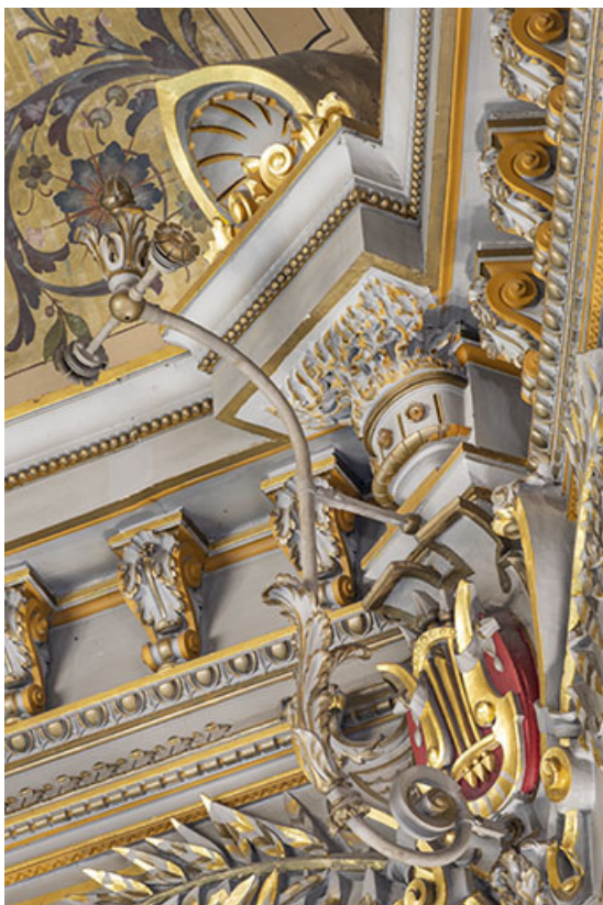
Grand Kursaal, salle : ancien appareil d'éclairage (décor à la rencontre de deux côtés). 25, Besançon, 2 place du Théâtre
