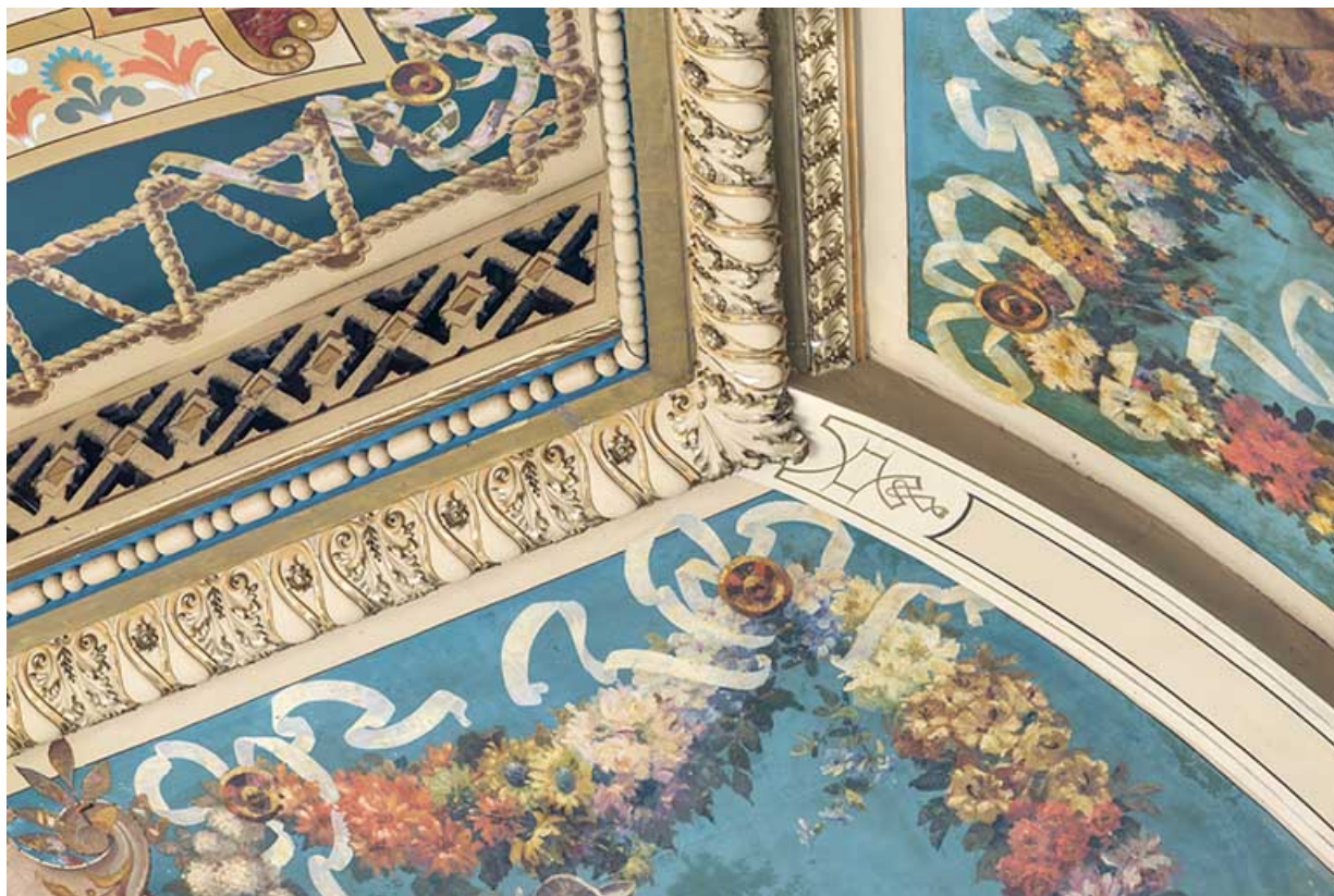
Grand Kursaal, salle : moulures au niveau de la fausse-coupoie.
