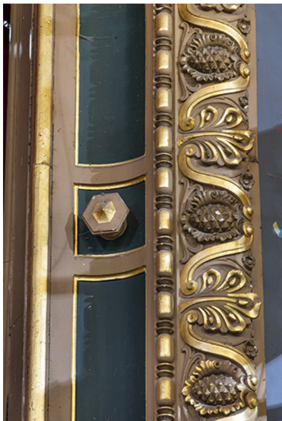
Grand Kursaal, salle : moulures du cadre de scène. 25, Besançon, 2 place du Théâtre
