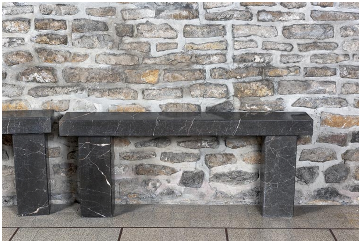
Clôture de chœur. Vue de face.
