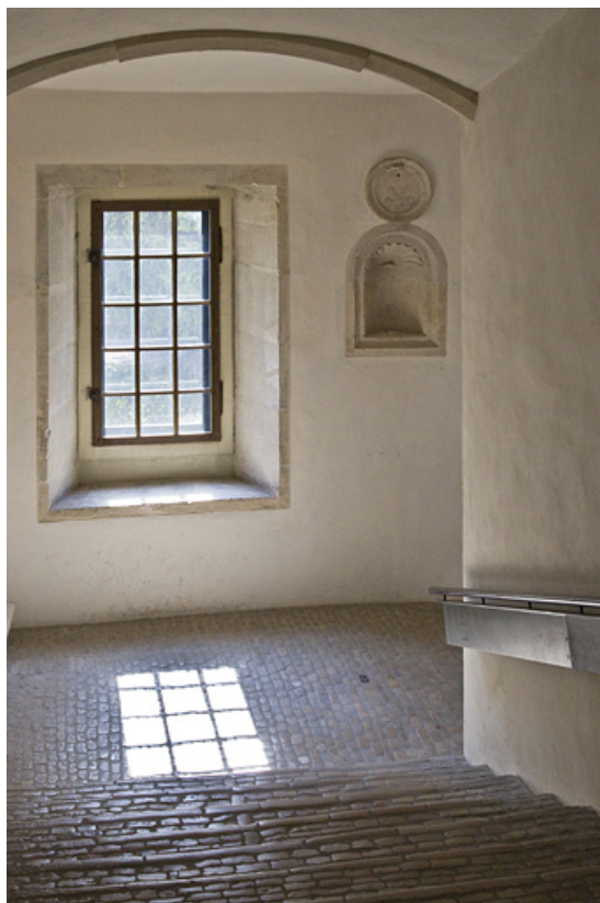
Médaillon ayant autrefois accueilli le profil du cardinal de Granvelle : vue d'ensemble depuis le palier du premier étage. 25, Besançon, 96 Grande Rue, lieudit : îlot Granvelle
