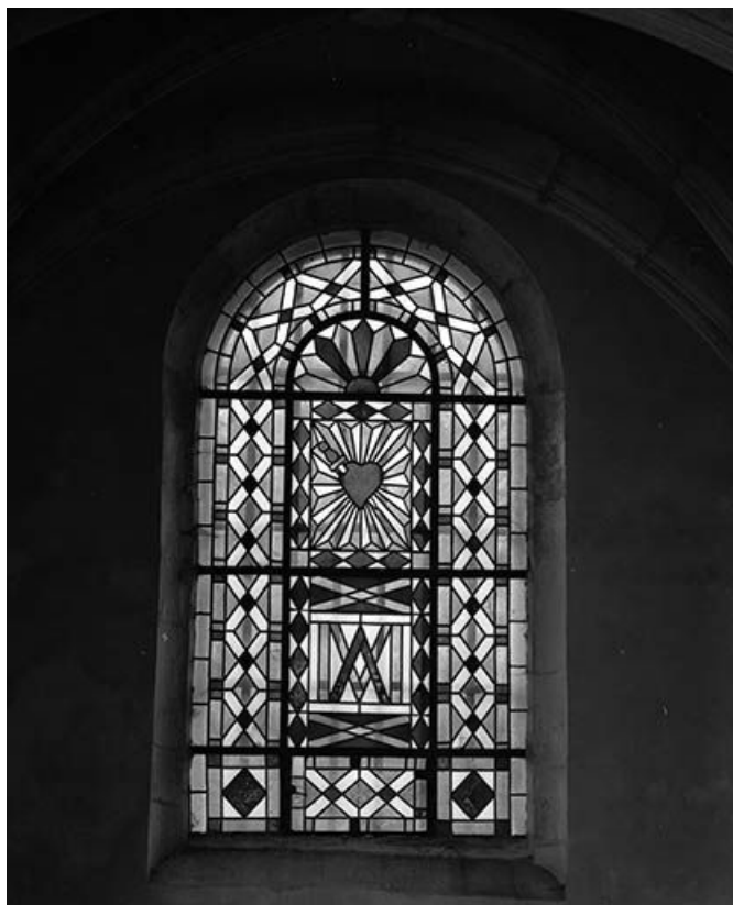
Baie 5 : vue générale.
