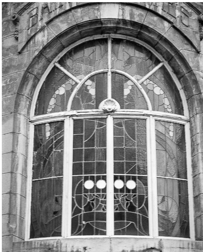
Baie cintrée vue de l'extérieur.
