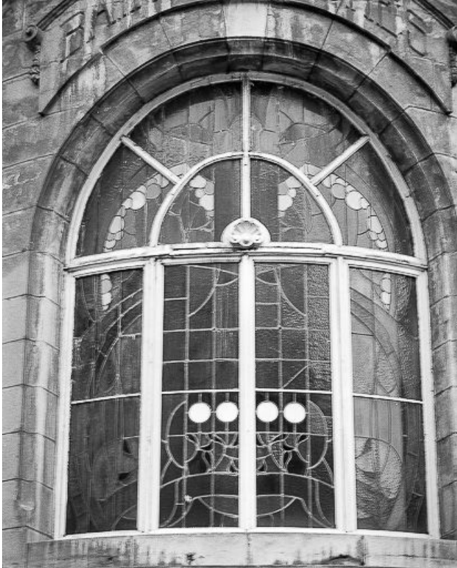
Baie cintrée vue de l'extérieur.
