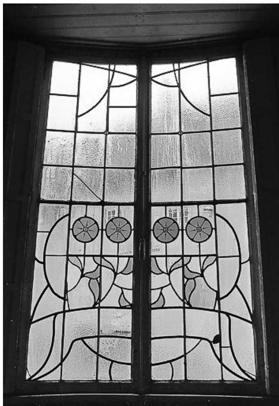
Baie cintrée vue de l'intérieur.
