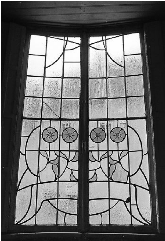
Baie cintrée vue de l'intérieur.
