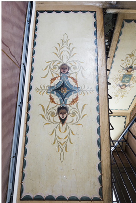
Plafond de la 1ère volée.
