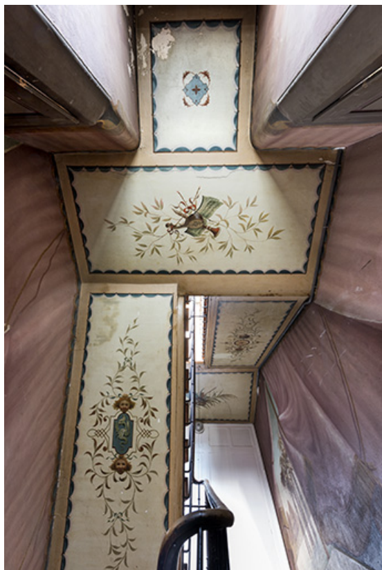
Plafond depuis le repos entre le 2e et le 3e palier (4e volée à gauche, 5e à droite). 25, Morteau, 8 rue Gonsalve Pertusier
