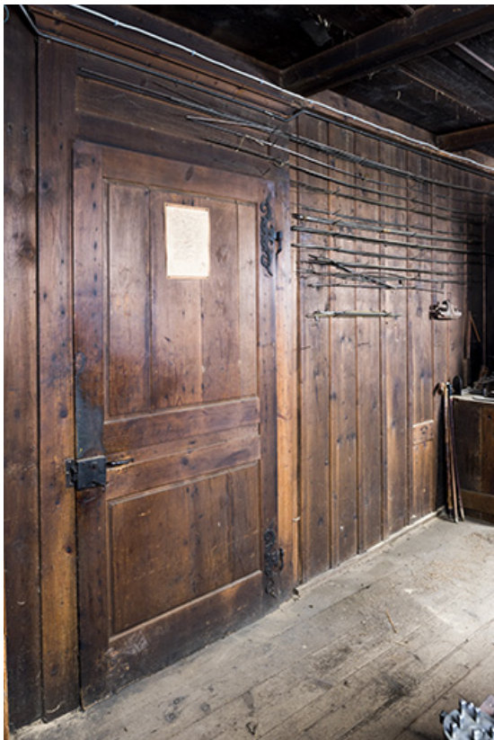
Stockage des barres métalliques, constituant l'une des matières premières de l'atelier. 25, Les Gras
