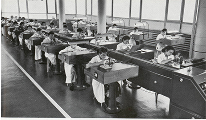
La chaîne de montage livre une montre en marche toutes les 25 secondes
