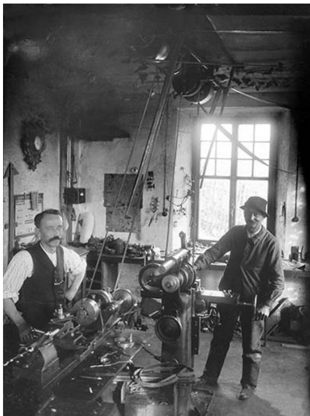
[Adelin Berçot, au premier plan, et un ouvrier dans l'atelier de mécanique], vers 1913. 25, Maïche, 13 rue Sous Montjoie
