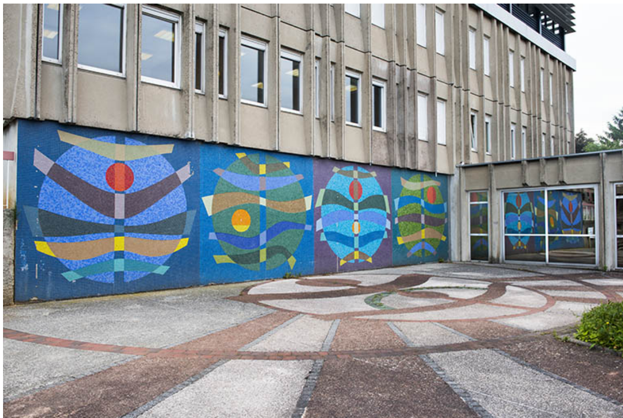
Détail façade, sol et mosaïque de l'externat.
