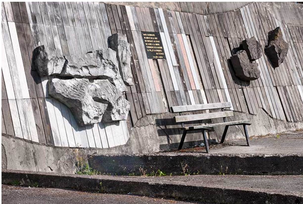
Vue de détail, depuis l'ouest.
