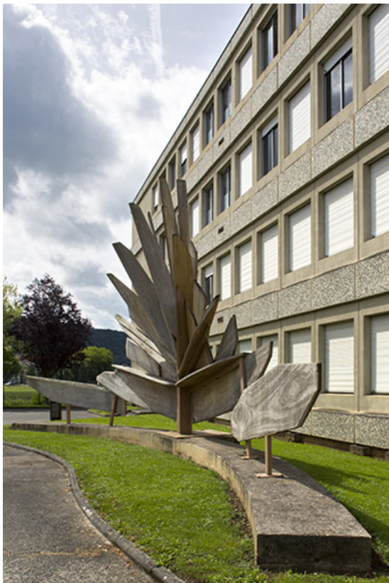
Vue de profil de l'oeuvre de Subirà-Puig devant la façade est de l'internat. 25, Baume-les-Dames, 16 rue de l' Helvétie
