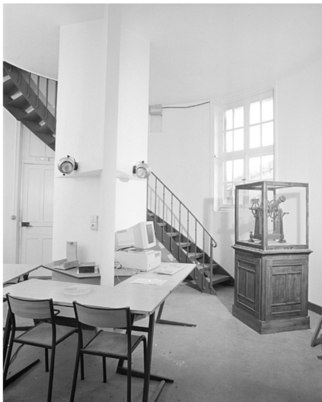
Pilier triangulaire supportant la lunette et escalier d'accès au dôme. 25, Besançon, 1 rue Labbé
