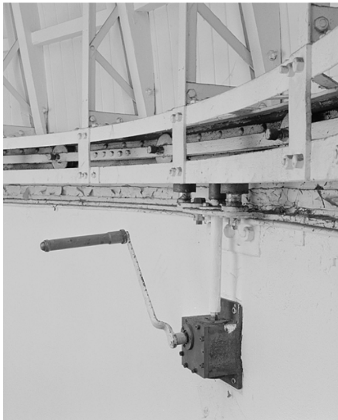
Système de rotation du dôme.
