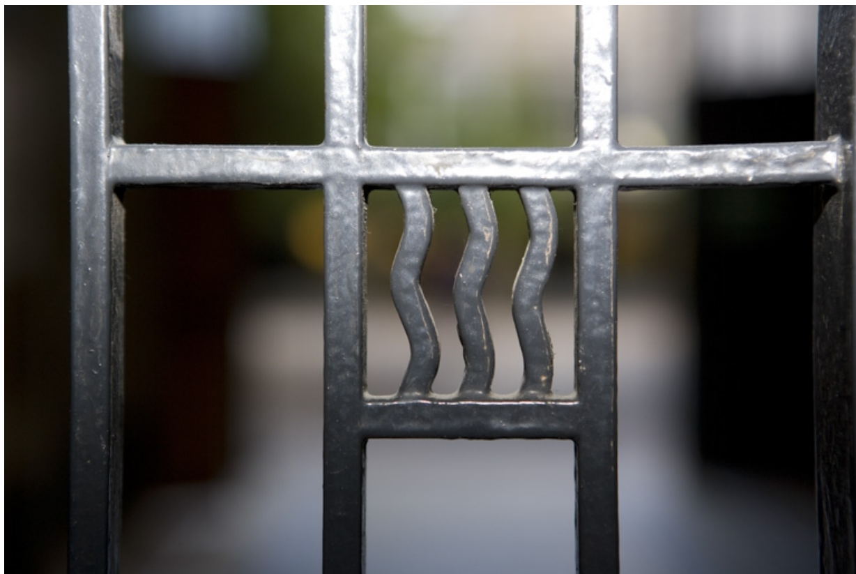
Porte à deux vantaux dans le passage couvert : détail du motif ondé. 25, Besançon, 1 rue Labbé
