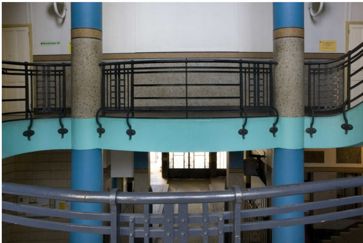
Garde-corps du grand escalier, au niveau du palier du premier étage.
