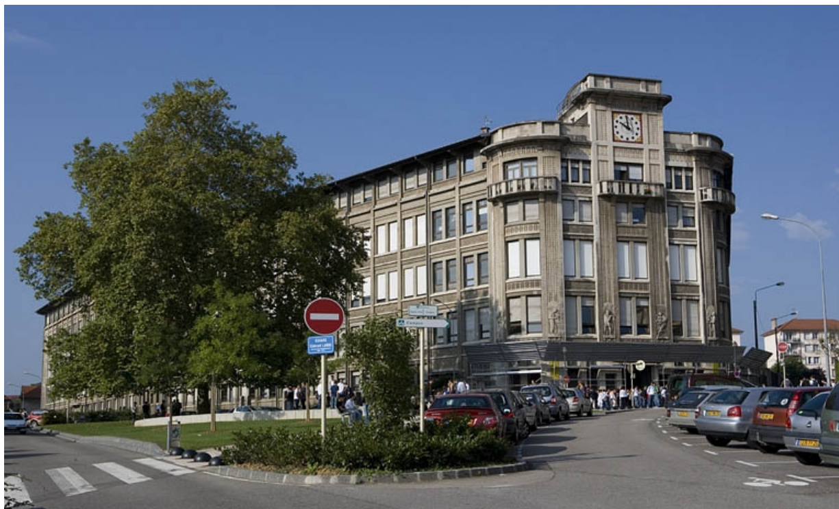
Vue d'ensemble de l'école, depuis l'est.
