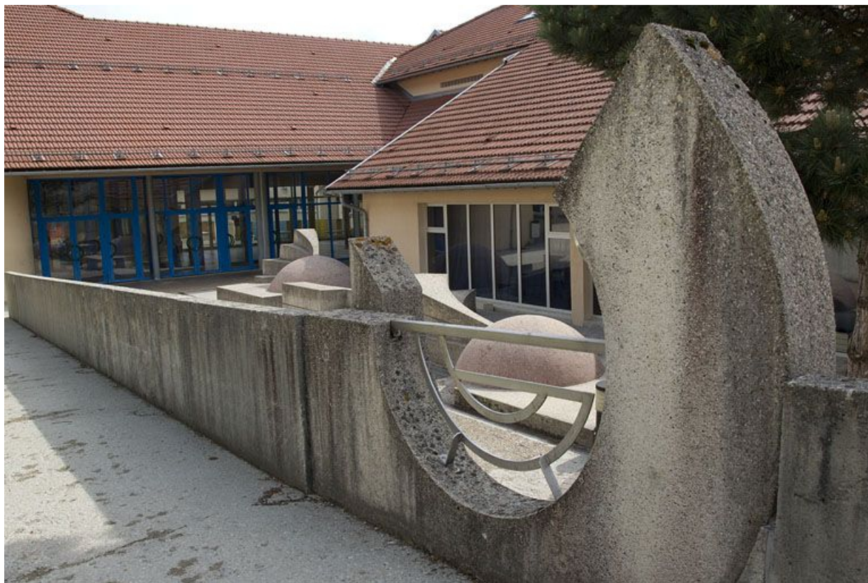
Vue d'ensemble depuis le motif inséré dans le muret, au sud.
