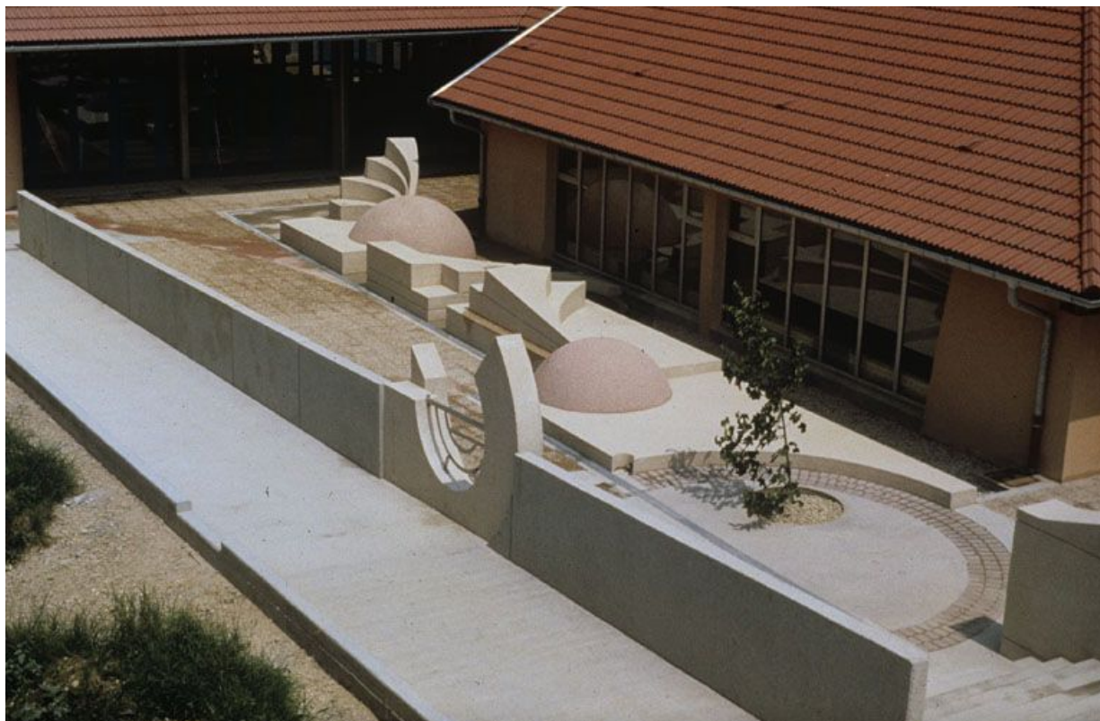
[Vue d'ensemble plongeante depuis l'entrée au sud], 1988.
