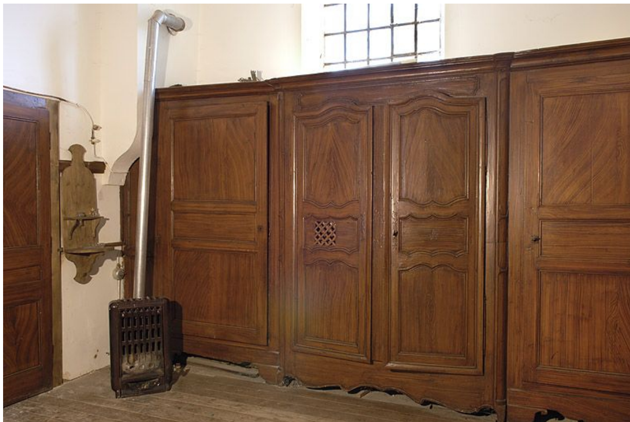
Les placards et le confessionnal à gauche de l'entrée. 25, Les Pontets
