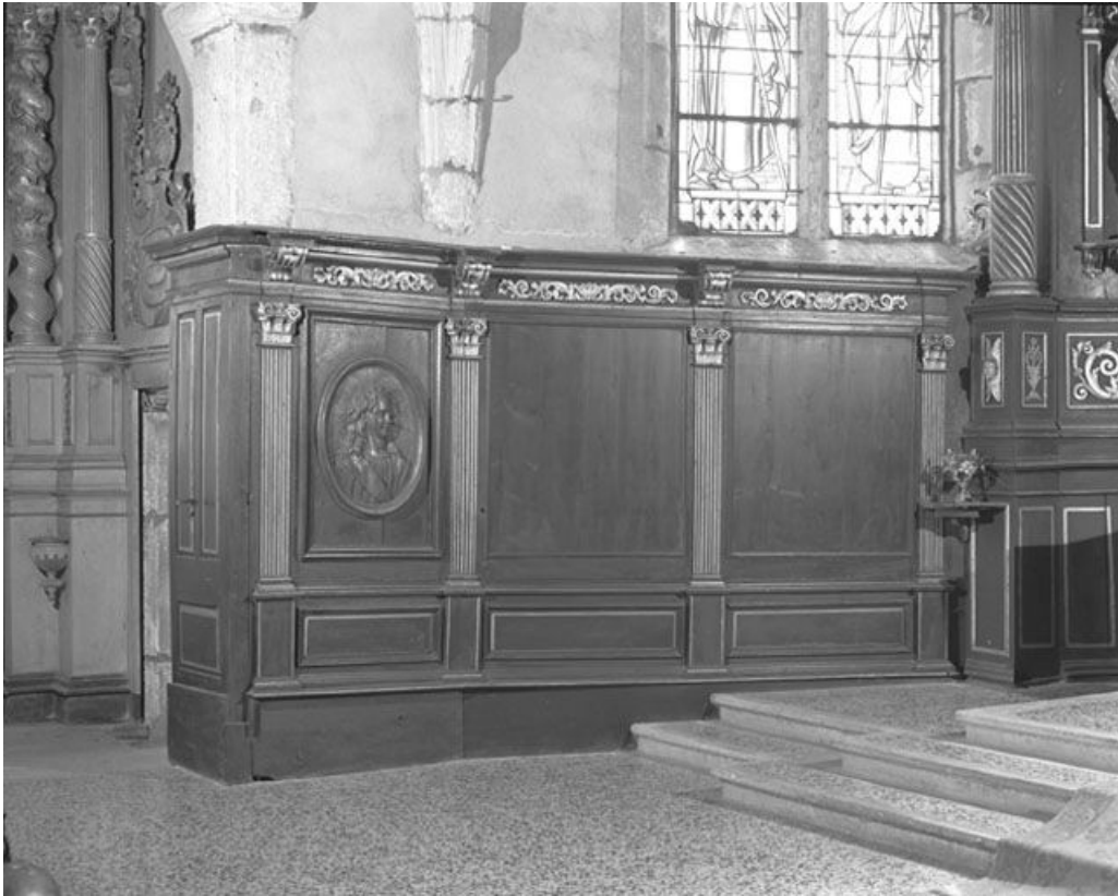
Vue d'ensemble du côté nord. 25, Chaux-Neuve
