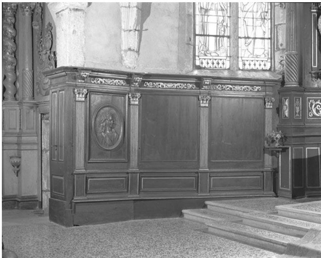
Vue d'ensemble du côté nord. 25, Chaux-Neuve
