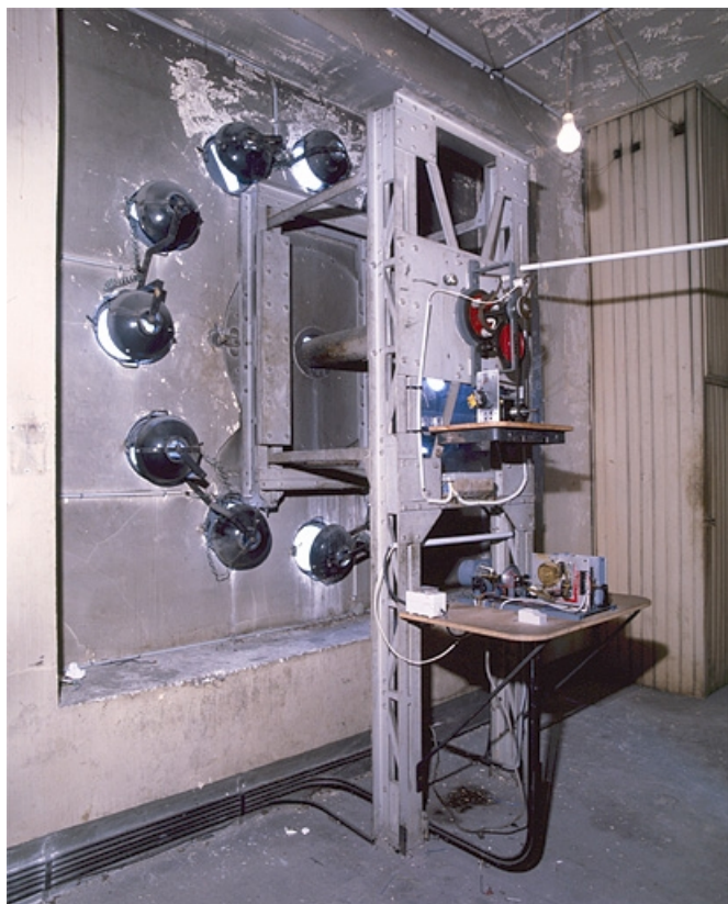
Le mouvement et le cadran, à l'intérieur du bâtiment.
