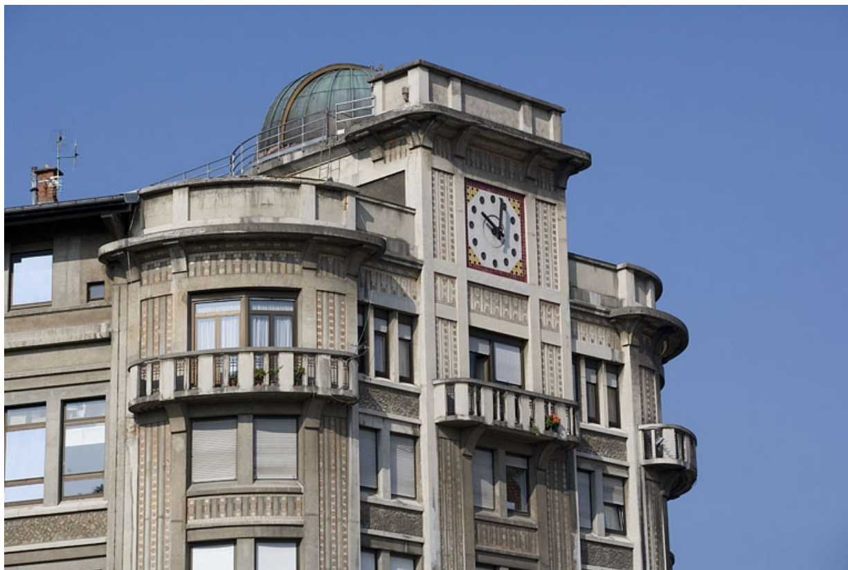
Partie supérieure du corps d'entrée et horloge.
