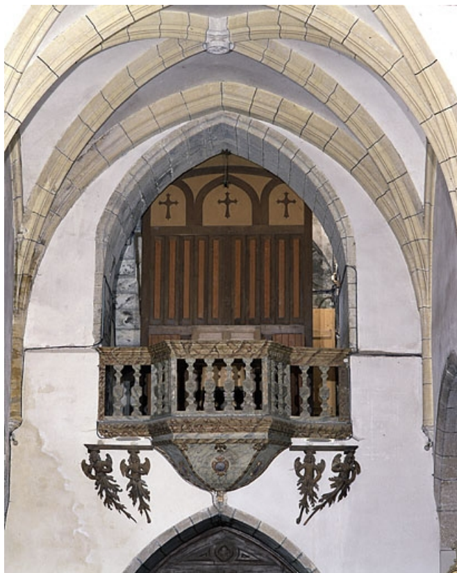
Vue générale de face. 25, La Rivière-Drueon
