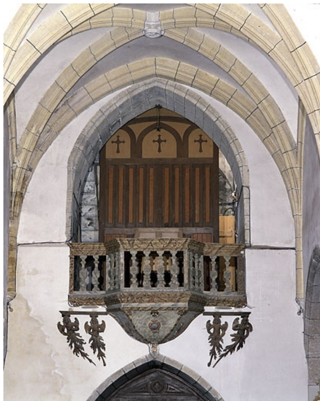
Vue générale de face. 25, La Rivière-Drueon
