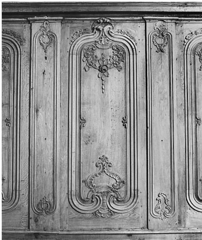
Détail : un des panneaux des lambris de demi-revêtement du chœur. 25, Vuillecin
