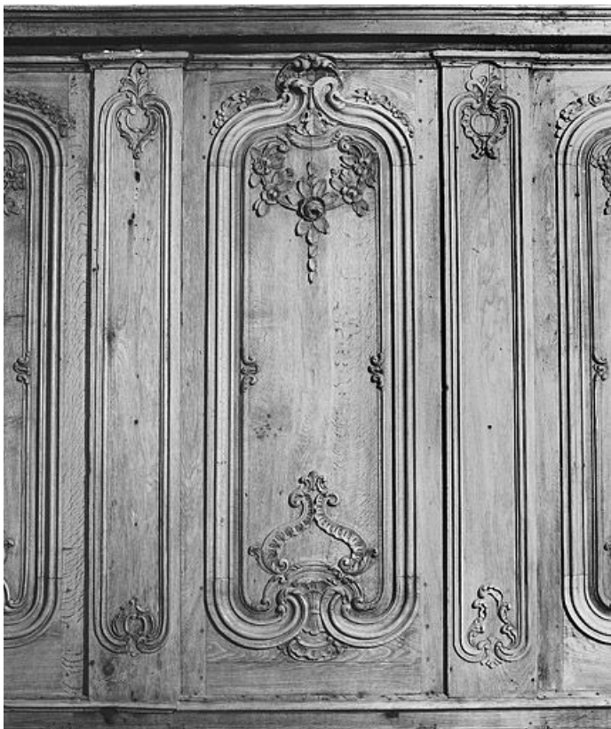
Détail : un des panneaux des lambris de demi-revêtement du chœur. 25, Vuillecin
