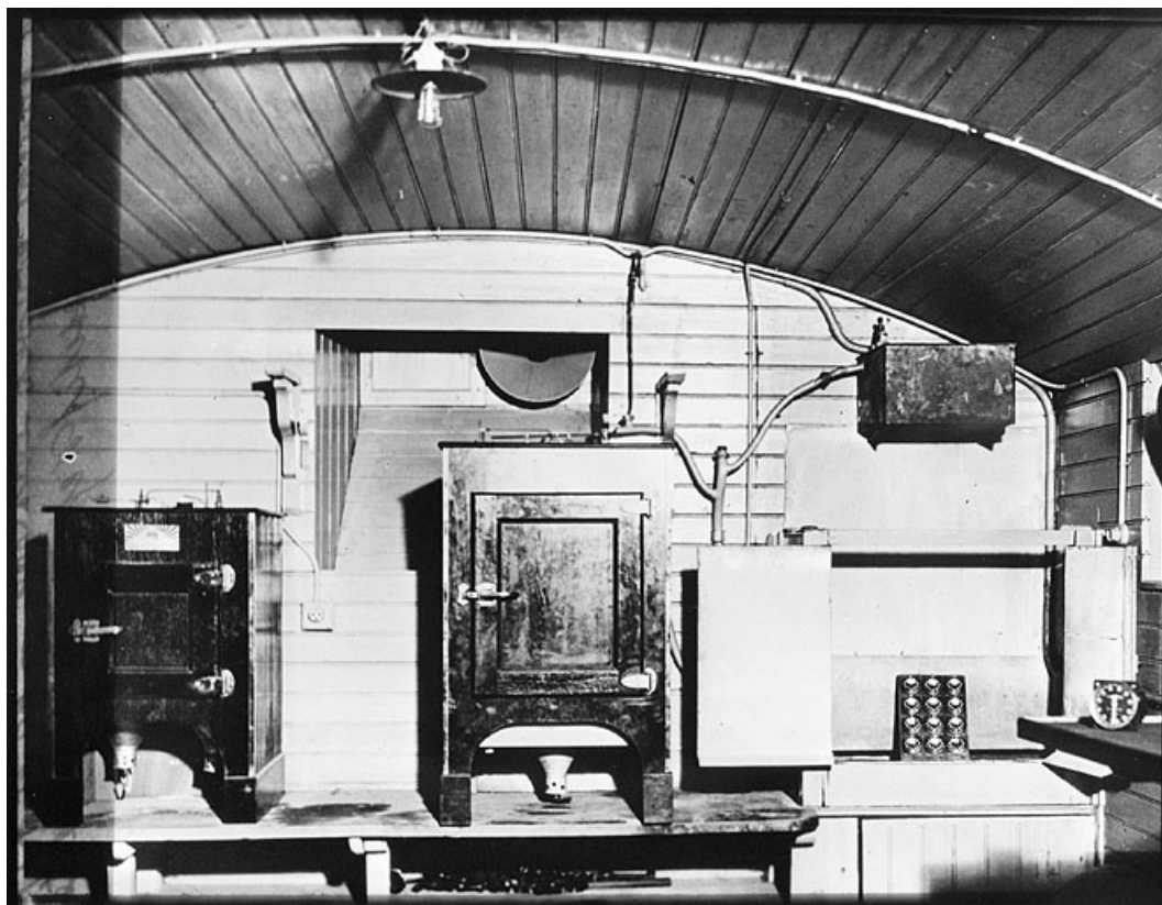
Epreuves thermiques. Etuves. Températures constantes de 40° et 15°, entre 1932 et 1934. 25, Besançon, 34, 36, 41 à 43 avenue de l' Observatoire, lieudit : la Bouloie
