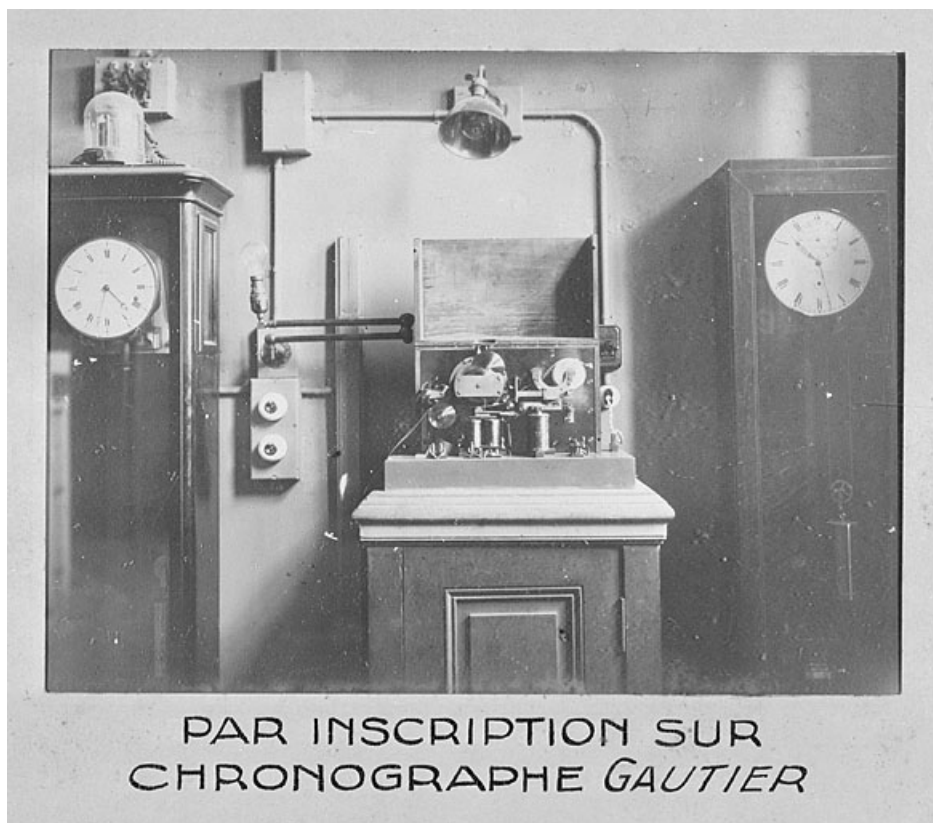
[Comparaison des montres] par inscription sur chronographe Gautier, entre 1932 et 1934. 25, Besançon, 34, 36, 41 à 43 avenue de l' Observatoire, lieudit : la Bouloie
