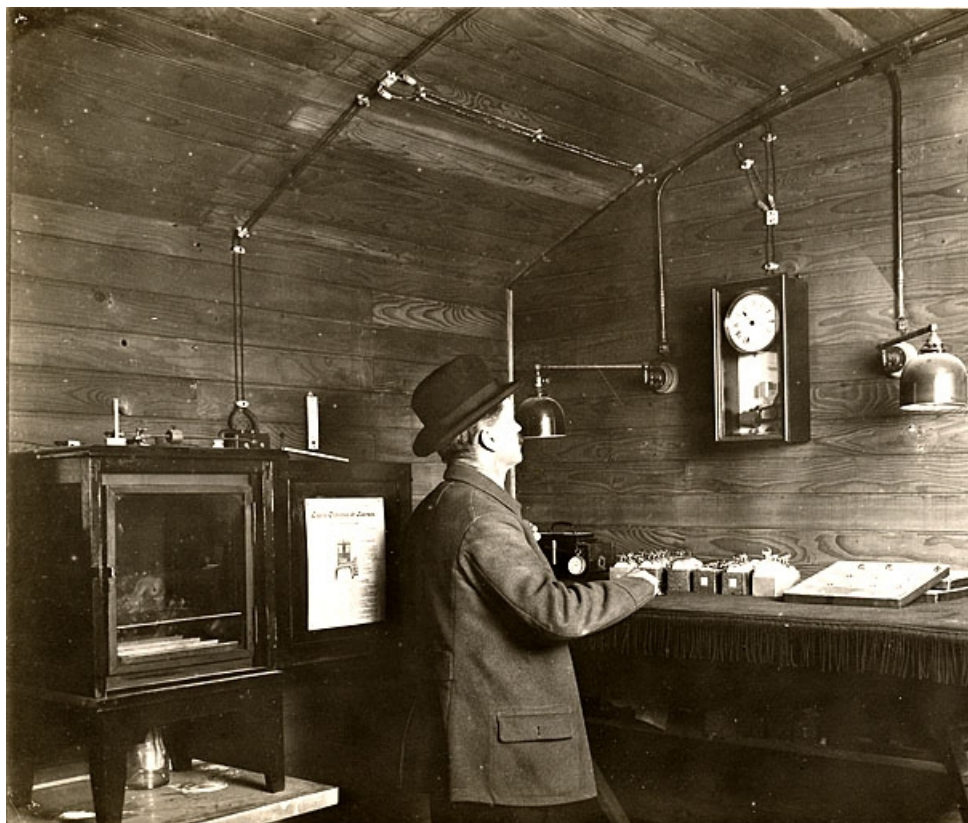
[Etuve de Kearson et contrôle des montres, au sous-sol du service chronométrique], 1er quart 20e siècle.
