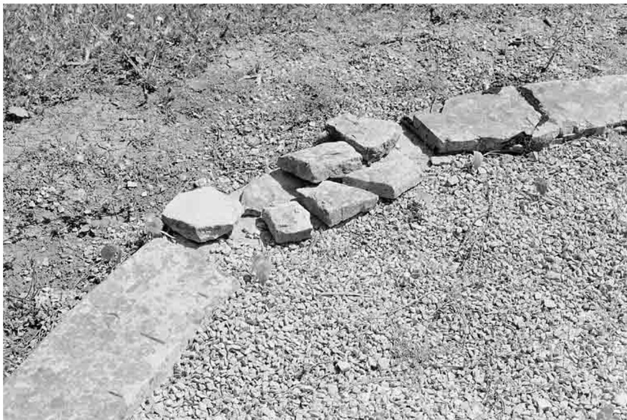
L'ellipse en pierre, avant restauration.
