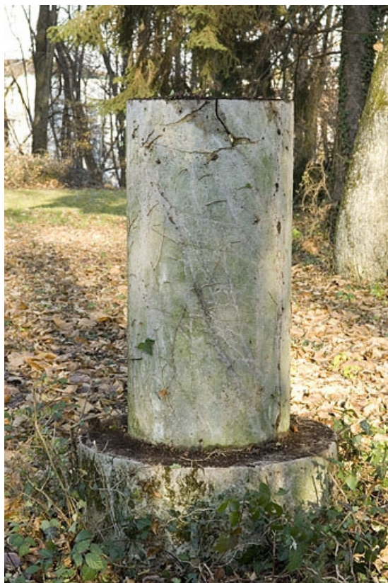
Pilier pour instrument mobile situé à l'emplacement du parc météorologique d'origine : vue rapprochée. 25, Besançon, 34, 36, 41 à 43 avenue de l' Observatoire, lieudit : la Bouloie
