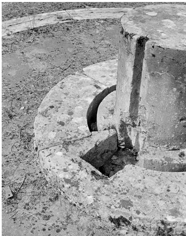
Base du pilier central, sur lequel reposait l'instrument. L'espace isole le pilier du sol du reste du bâtiment. 25, Besançon, 34, 36, 41 à 43 avenue de l' Observatoire, lieudit : la Bouloie
