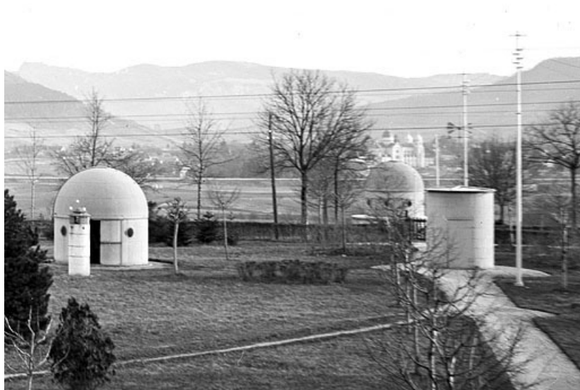
[Les coupoles de l'altazimut (à gauche) et de l'équatorial photographique (à droite)], 1914. 25, Besançon, 34, 36, 41 à 43 avenue de l' Observatoire, lieudit : la Bouloie
