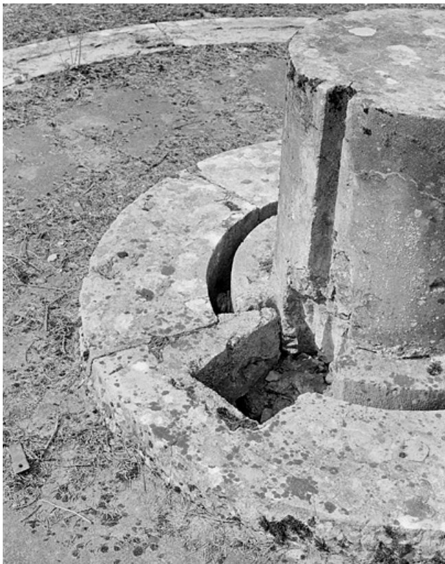
Base du pilier central, sur lequel reposait l'instrument. L'espace isole le pilier du sol du reste du bâtiment. 25, Besançon, 34, 36, 41 à 43 avenue de l' Observatoire, lieudit : la Bouloie
