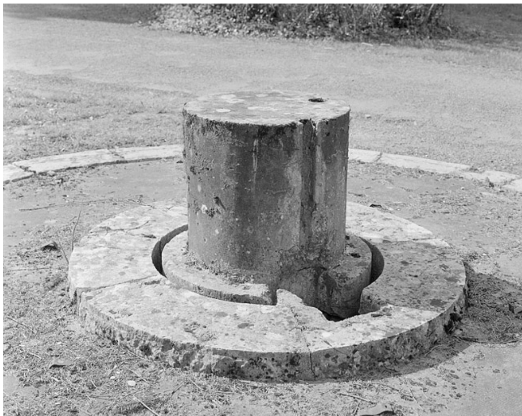
Base du pilier central, sur lequel reposait l'instrument. Noter la rainure ménagée pour la câble du poids du moteur de la lunette. 25, Besançon, 34, 36, 41 à 43 avenue de l' Observatoire, lieudit : la Bouloie
