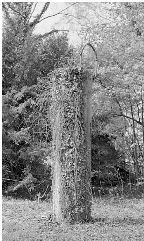
Pilier nord de la mire nord : vue latérale.
