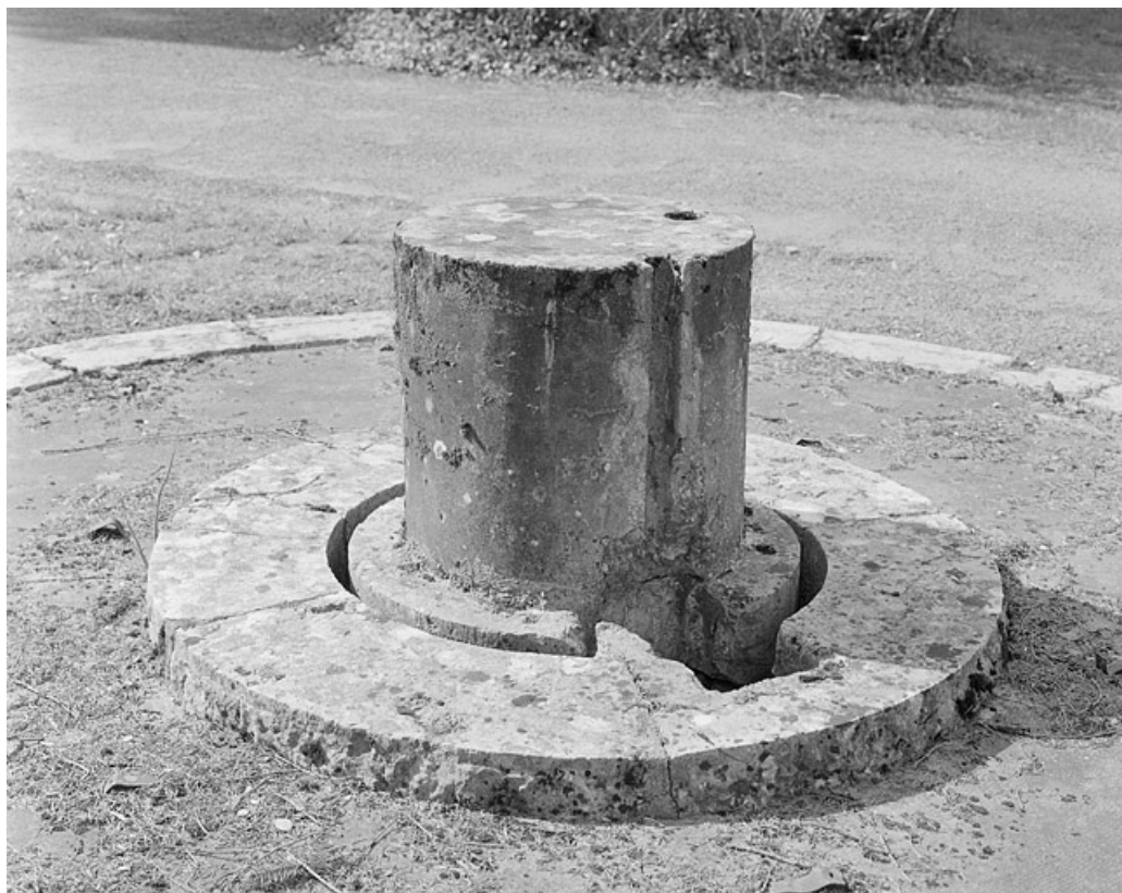
Base du pilier central, sur lequel reposait l'instrument. Noter la rainure ménagée pour la câble du poids du moteur de la lunette. 25, Besançon, 34, 36, 41 à 43 avenue de l' Observatoire, lieudit : la Bouloie
