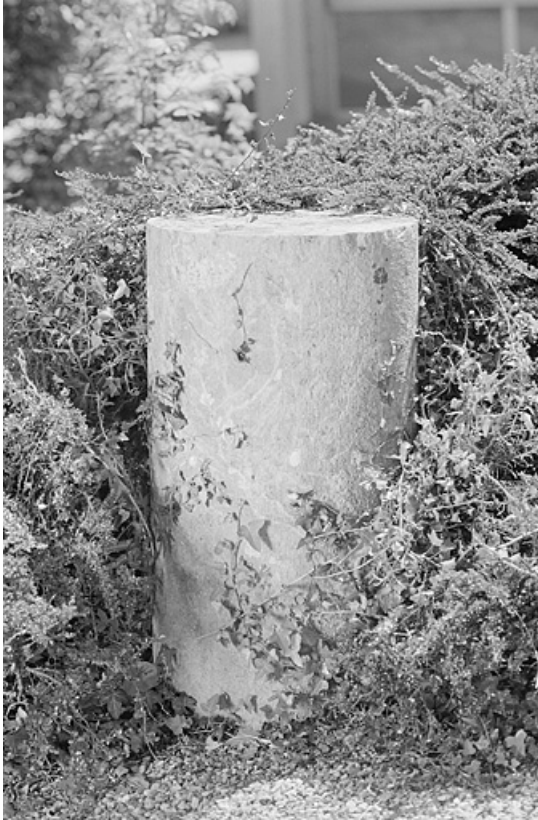
Pilier pour instrument mobile, à l'avant du laboratoire d'essais et bureaux (partie sud du site).
