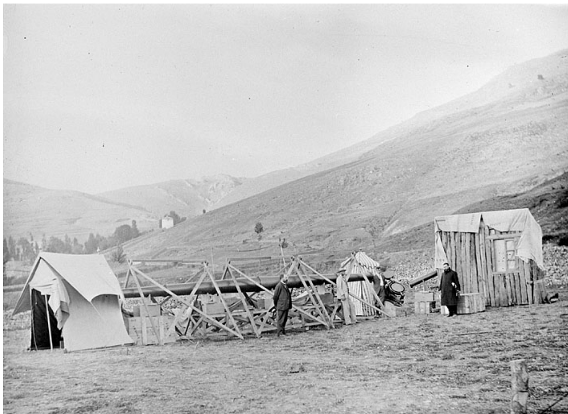
[Cistierna. Vue d'ensemble de l'installation Hamy], 1905.
