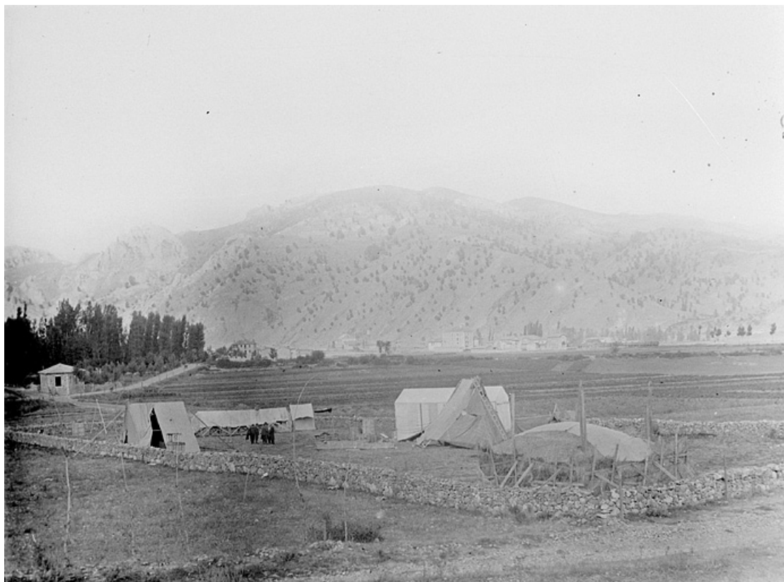
Cistierna. Août 1905. Mission Hamy. Vue prise du NW. Installation électrique.
