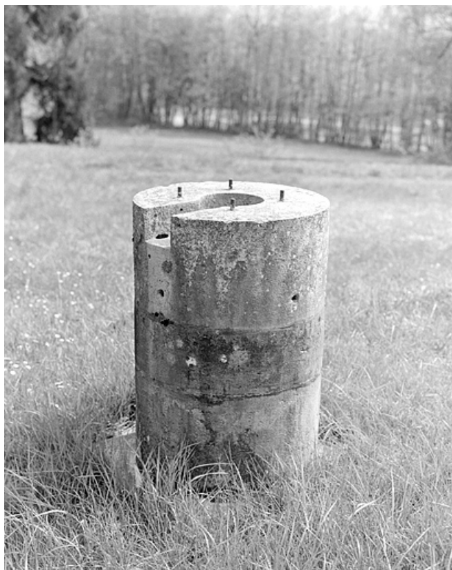
Pilier pour instrument mobile, à l'arrière du laboratoire d'essais et bureaux (partie sud du site). 25, Besançon, 34, 36, 41 à 43 avenue de l' Observatoire, lieudit : la Bouloie
