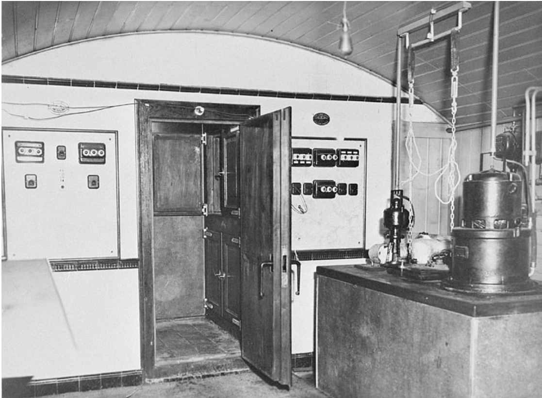
Epreuves thermiques. Frigorifique Barthod Système Eyscher Wiss. Températures de 4°, 0°, -10° et -20°, entre 1932 et 1934. 25, Besançon, 34 avenue de l' Observatoire, lieudit : la Bouloie
