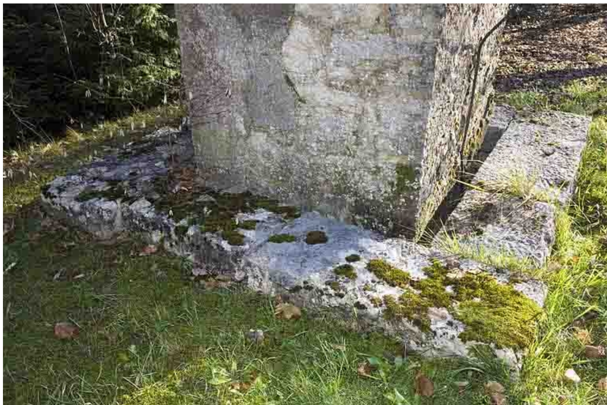
Mire sud de la lunette méridienne, pilier sud : fossé de stabilisation à la base du pilier. 25, Besançon, 34 avenue de l' Observatoire, lieudit : la Bouloie
