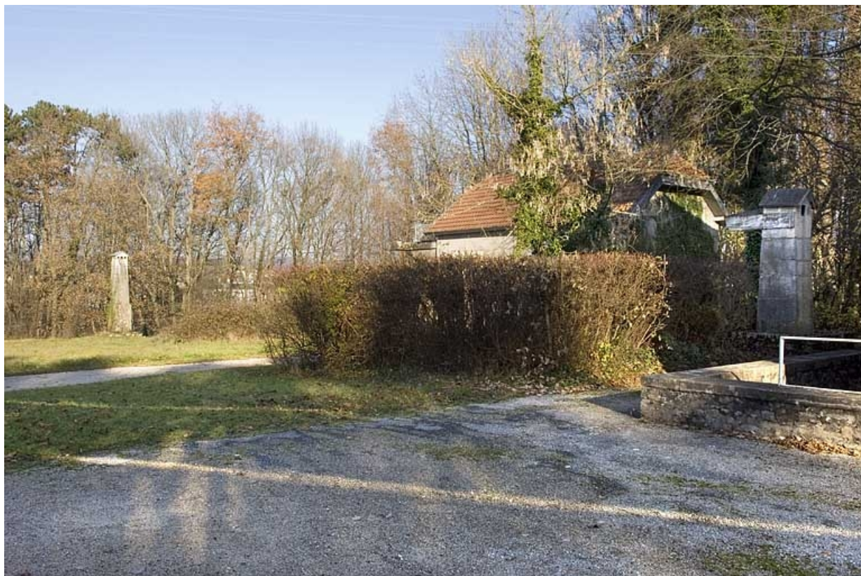
Mire nord de la lunette méridienne : pilier nord à gauche (mire) et pilier sud à droite (collimateur). 25, Besançon, 34 avenue de l' Observatoire, lieudit : la Bouloie
