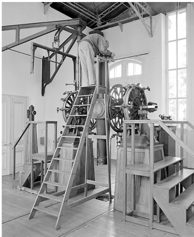
Utilisation de l'escabeau à marches, avec la lunette à la verticale pour les observations nadirales.
