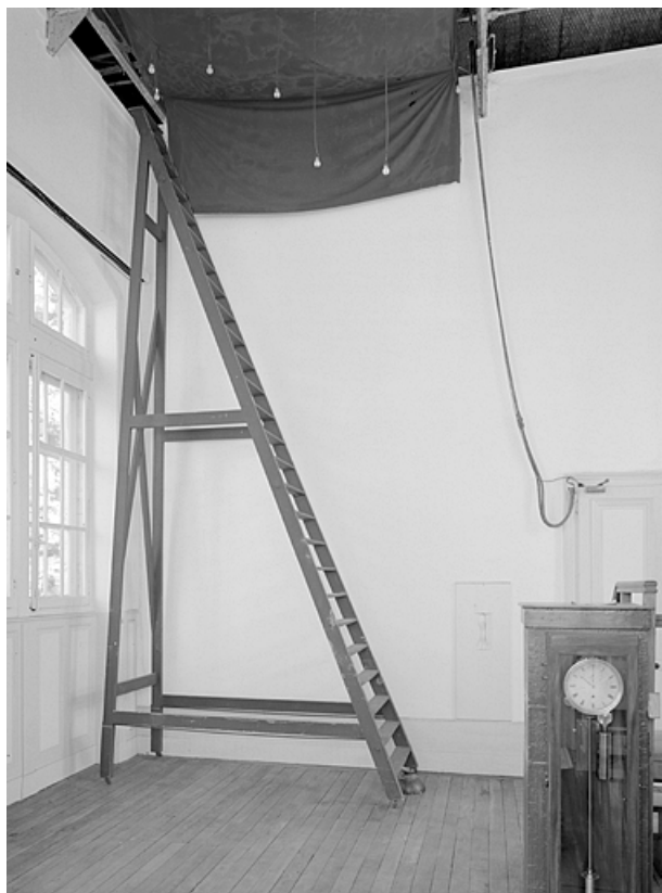
L'échelle permettant d'accéder au système d'ouverture de la toiture.
