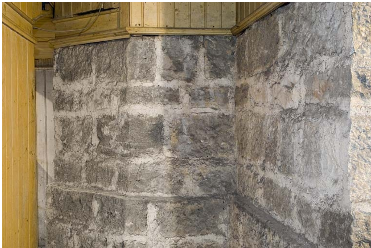
Vue latérale du pilier destiné à l'horloge Fénon n° 30, visible depuis le sous-sol. 25, Besançon, 34 avenue de l' Observatoire, lieudit : la Bouloie
