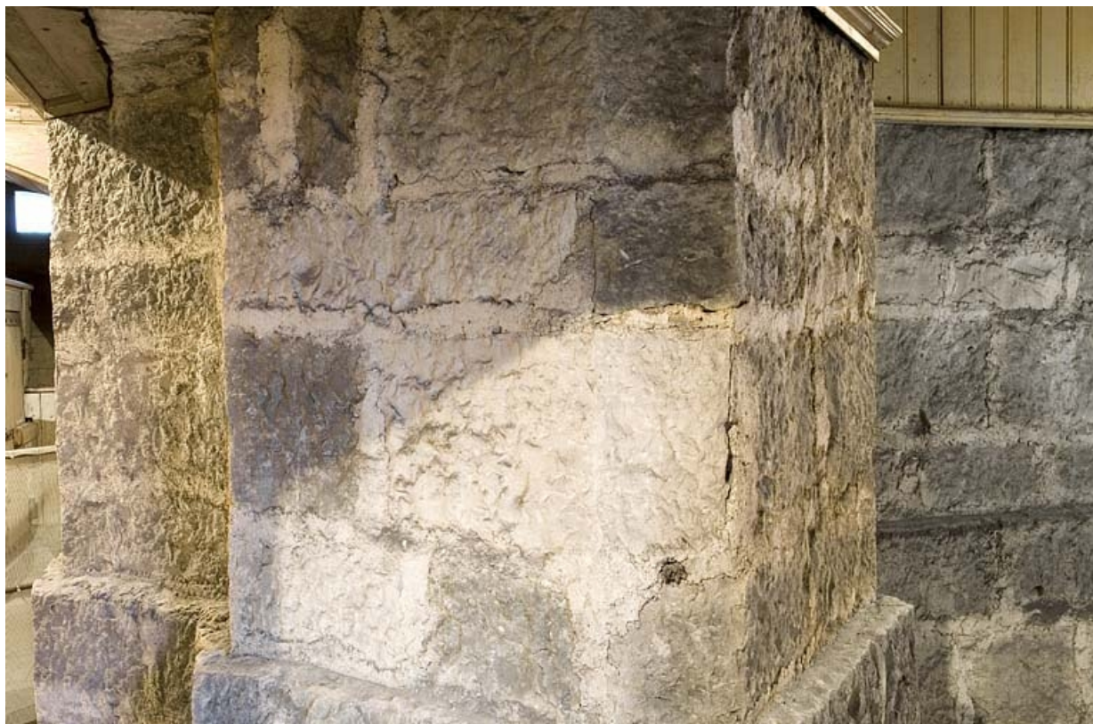
Vue de face du pilier destiné à l'horloge Fénon n° 30, visible depuis le sous-sol.
