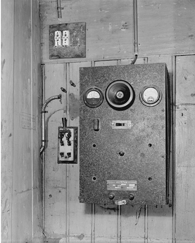
Chargeur de batterie Oxymétal Westinghouse : vue d'ensemble.
