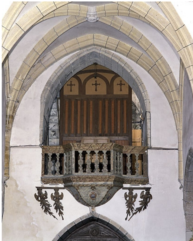
Vue générale de face. 25, La Rivière-Drueon
