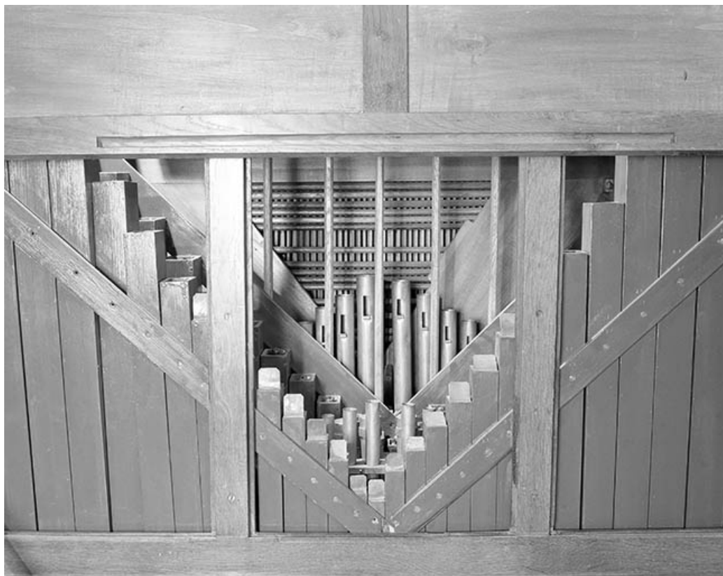
Tuyauterie vue de face.
