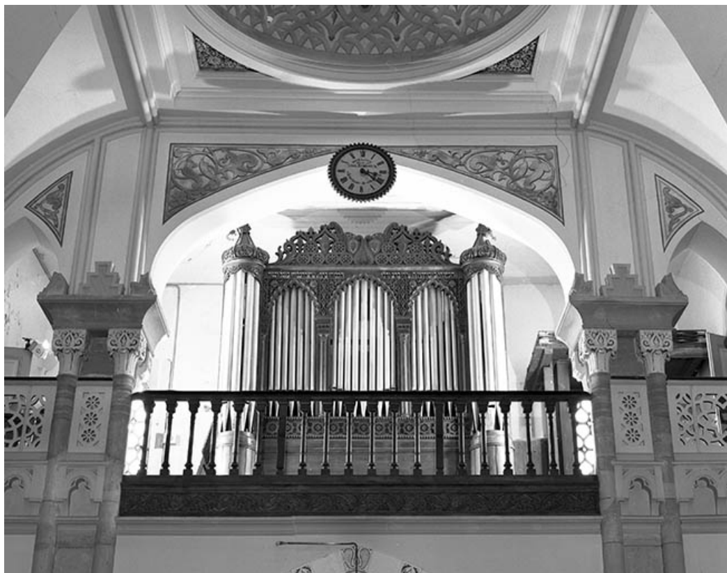
Vue générale de face en contre-plongée.
