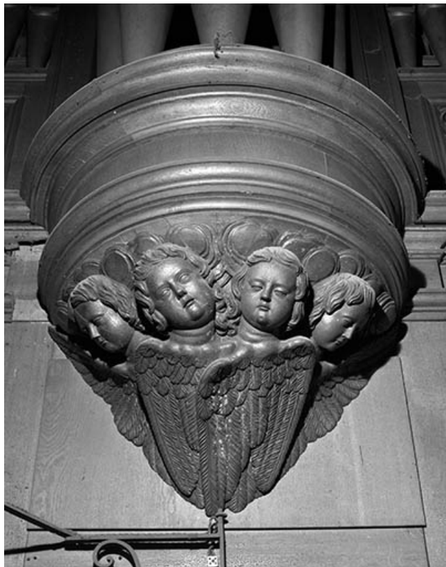
Culot de la tourelle centrale vu de face avant restauration.
