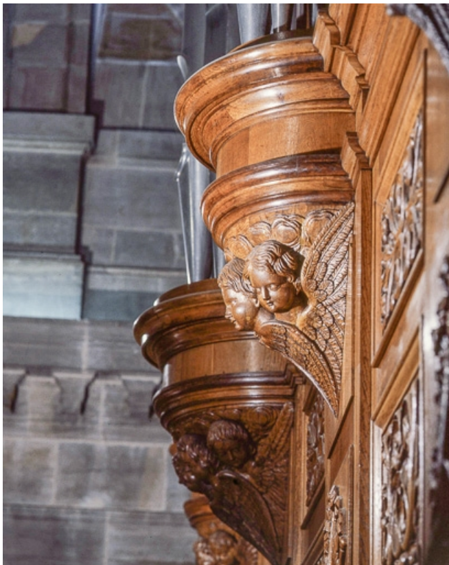
Culot d'une tourelle latérale vu de trois quarts après restauration. 25, Besançon rue de la Madeleine
