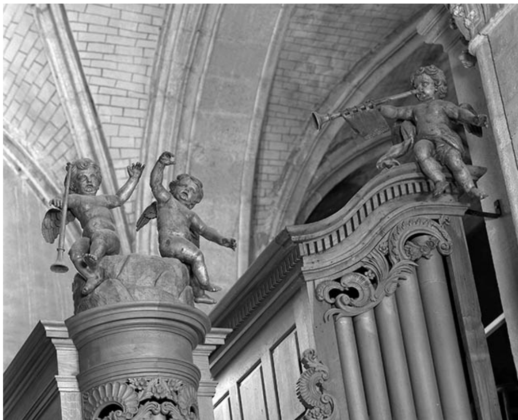
Couronnement de la tourelle centrale et de la tourelle droite.
