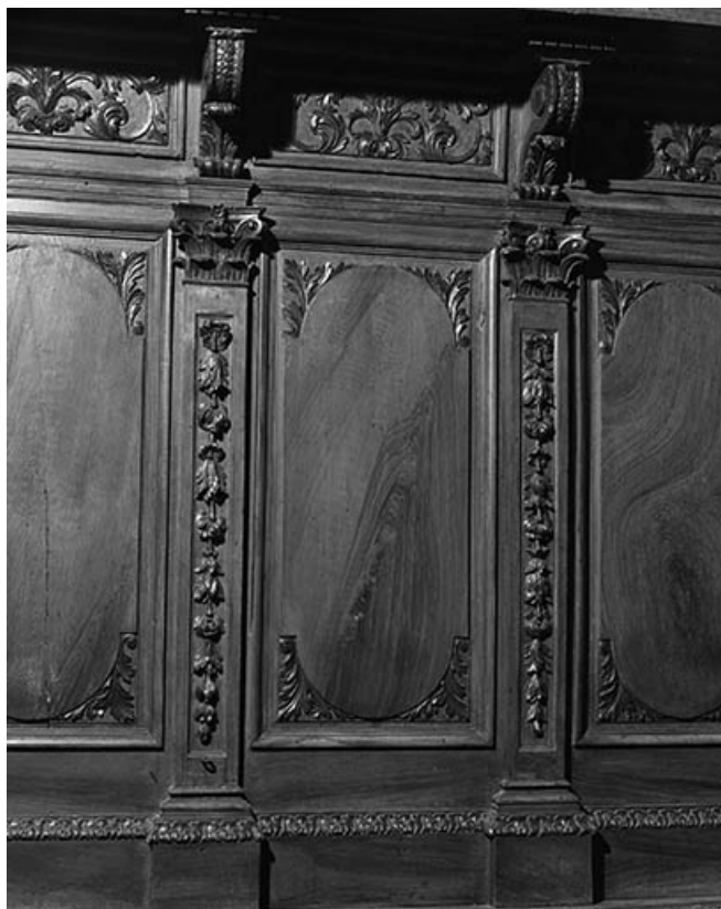
Vue d'un panneau des lambris de demi-revêtement. 25, Vuillafans
