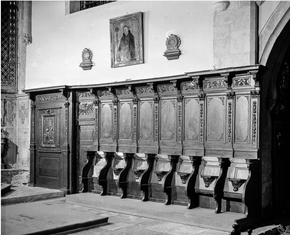
Vue d'ensemble côté sud en direction du choeur. 25, Vuillafans
