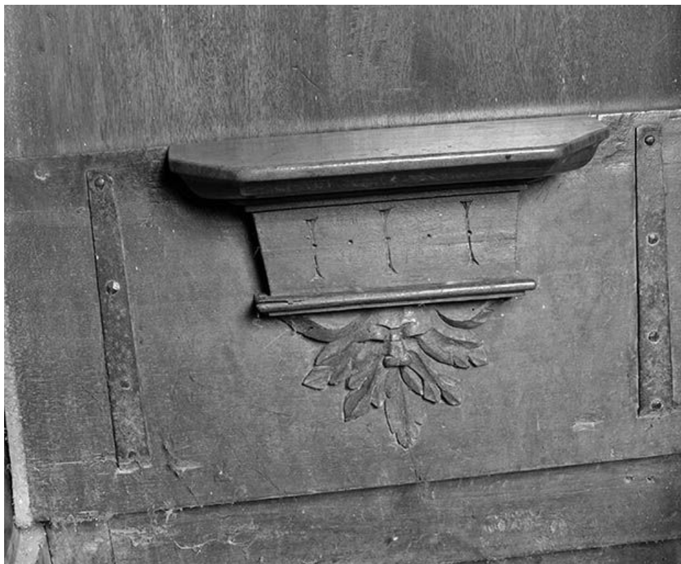
Détail : miséricorde côté sud n° 3. 25, Lods
