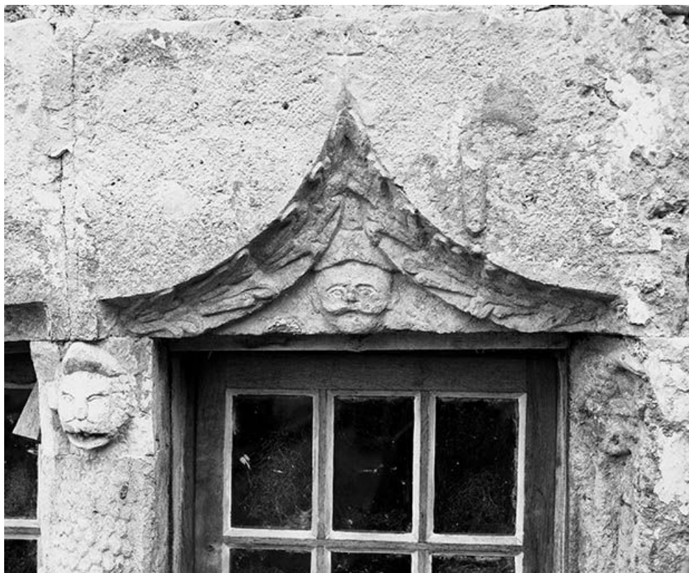
Détail du linteau de la baie gauche du rez-de-chaussée, côté cour. 25, Ornans, 4 rue du Charri
