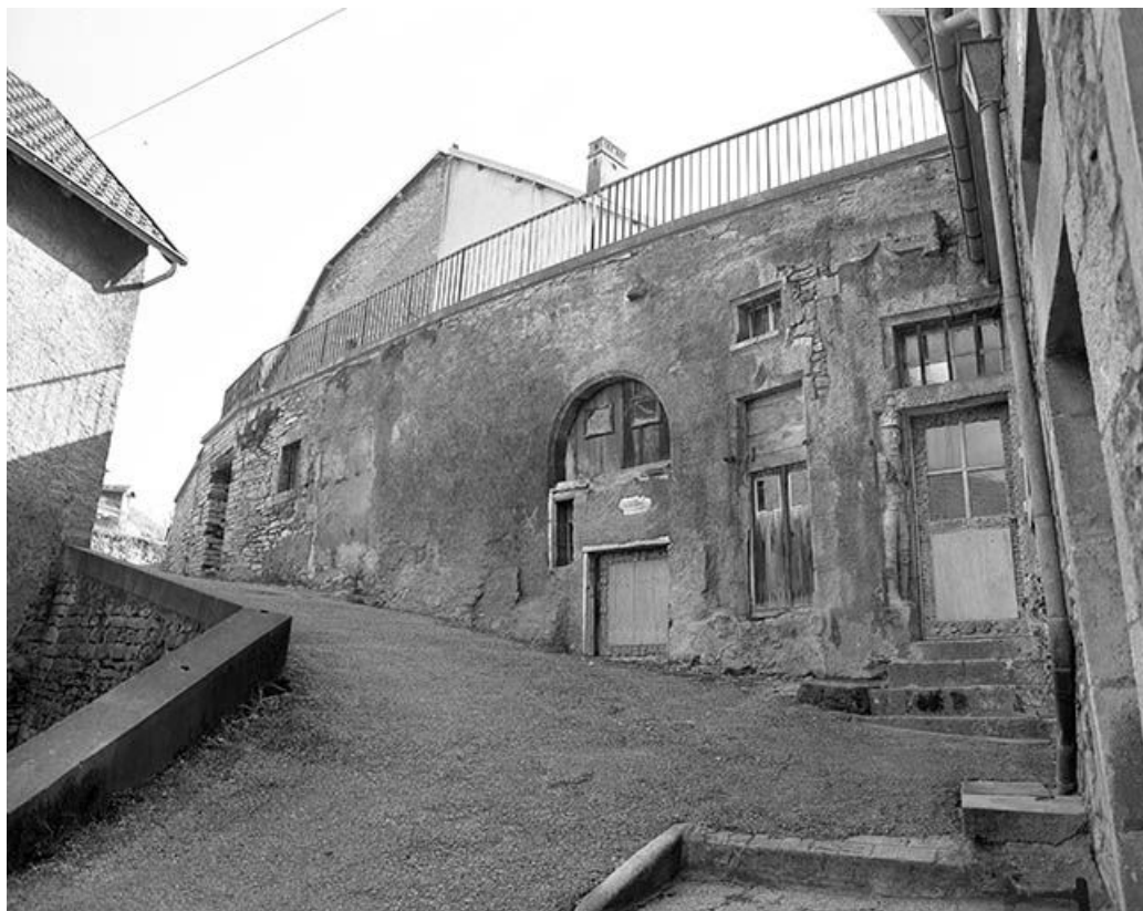
Vue rapprochée des élévations rue du Charri.
