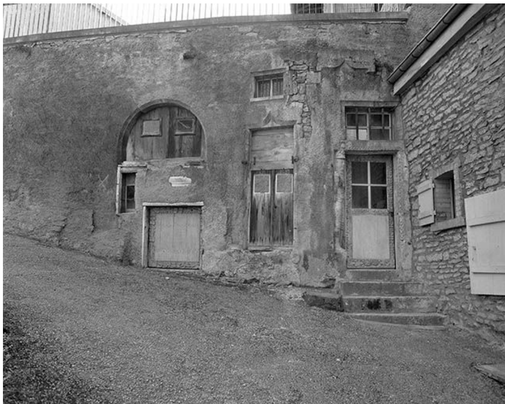
Vue de face des élévations rue du Charri.
