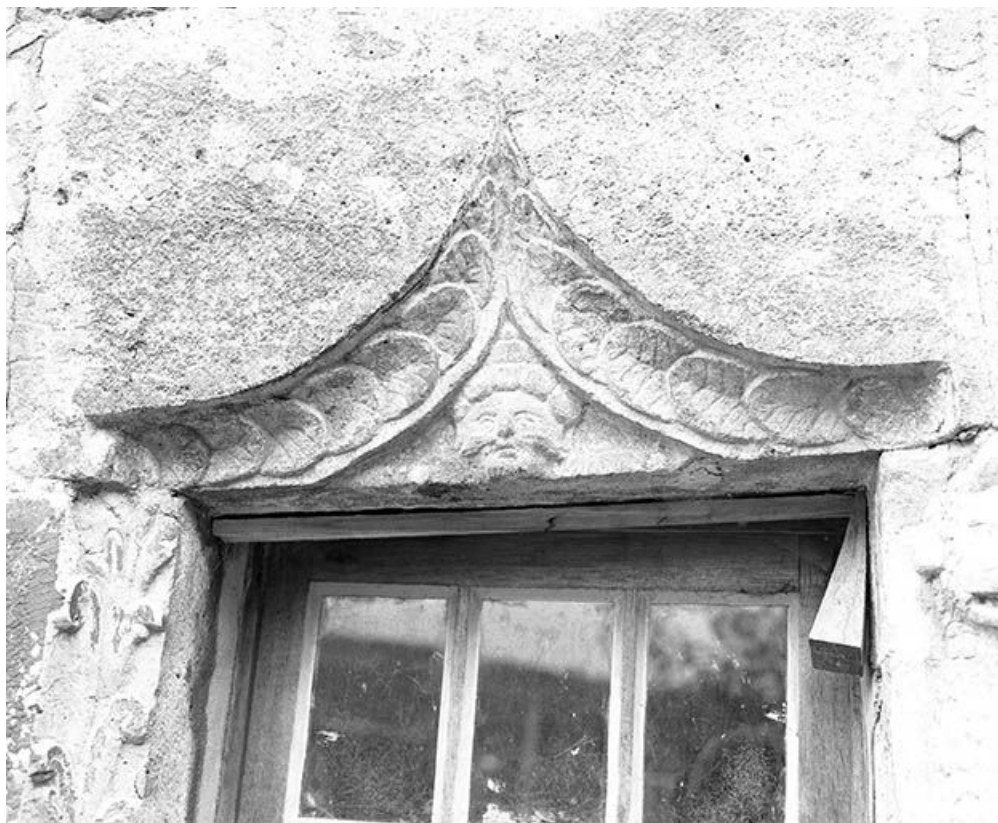
Détail du linteau de la baie gauche au rez-de-chaussée, côté cour. 25, Ornans, 4 rue du Charri
