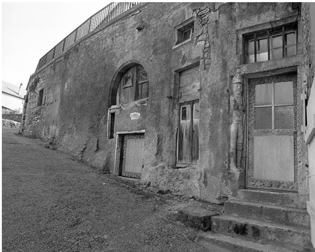
Vue de trois quart droit des élévations rue du Charri.
