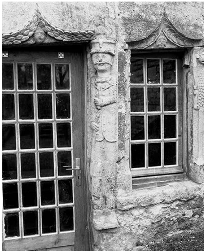
Détail de la porte du côté cour : le piédroit droit.
