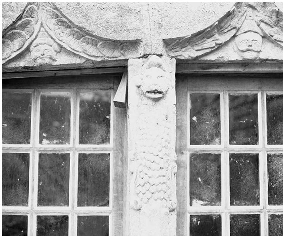
Détail du piédroit et des baies au rez-de-chaussée, côté cour. 25, Ornans, 4 rue du Charri
