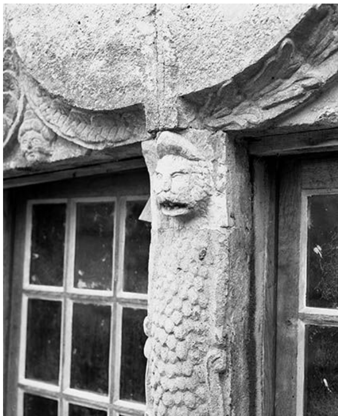
Détail du piédroit des baies au rez-de-chaussée, côté cour. 25, Ornans, 4 rue du Charri
