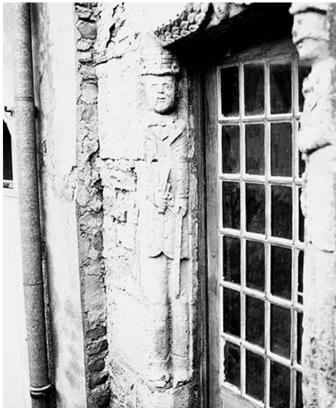
Détail de la porte du côté cour : le piédroit gauche.
