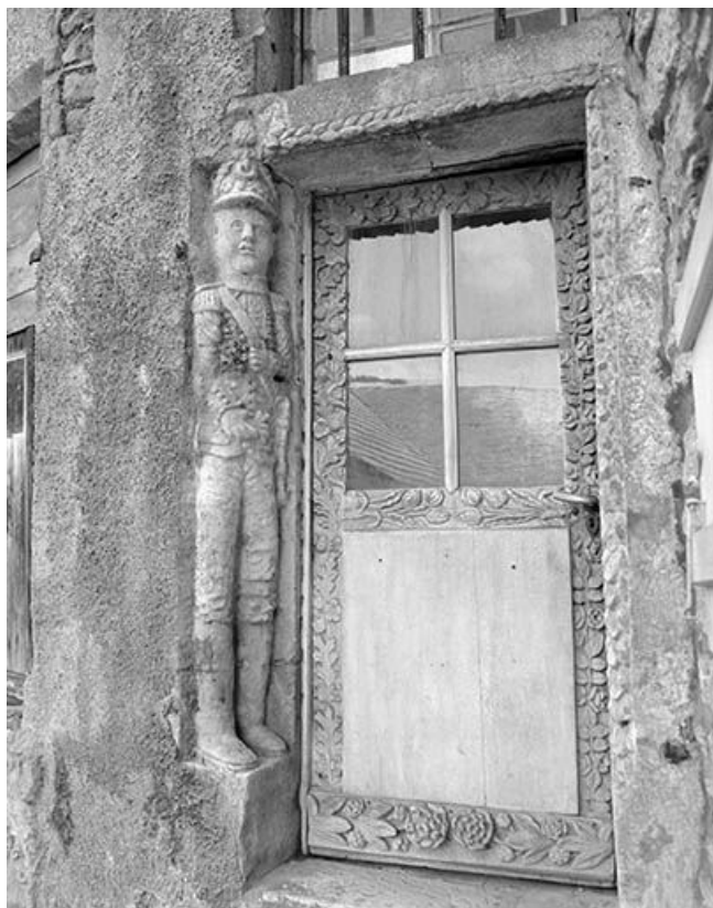
Porte d'entrée vue de trois quart droit.
