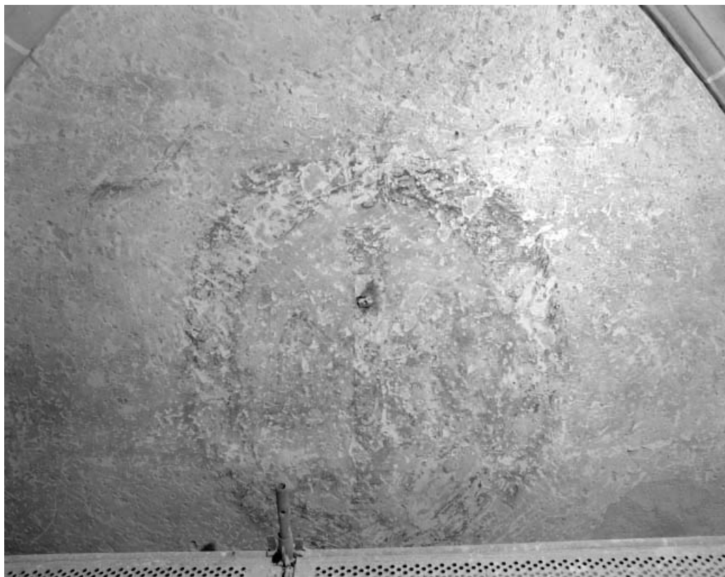
Mur sud de la 1ère travée de la nef.
