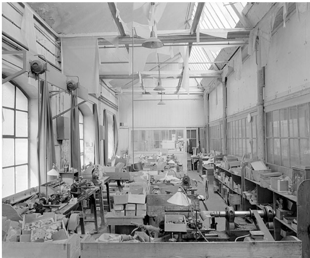
Vue des machines de l'atelier de finissage depuis l'extrémité est.
