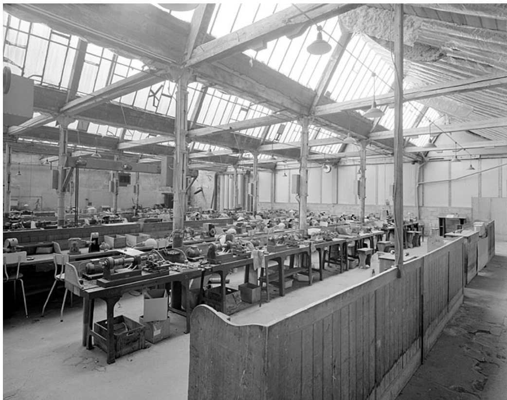
Vue des machines de l'atelier principal depuis le sud-ouest.
