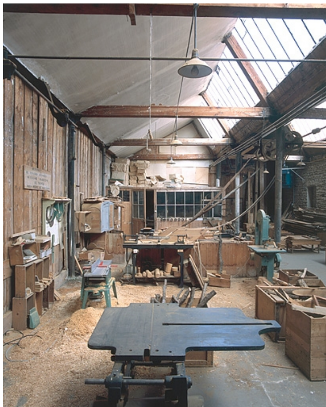
Atelier de menuiserie. Distribution par courroies obliques des machines situées au sud de l'atelier. 25, Baume-les-Dames rue des Pipes, lieudit : Gondé
