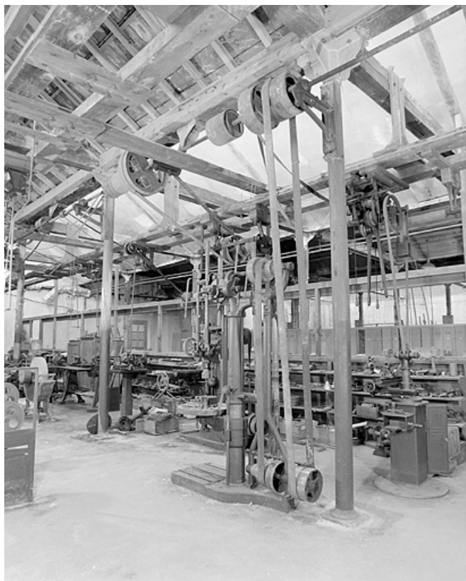
Atelier de mécanique. Transmission par courroies verticales de la perceuse à colonne. 25, Baume-les-Dames rue des Pipes, lieudit : Gondé
