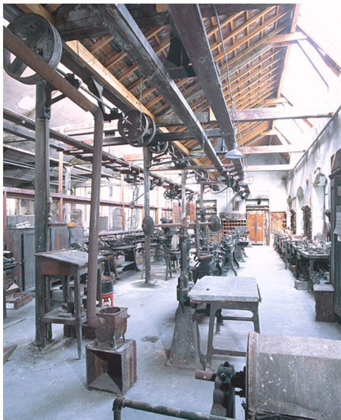
Atelier de mécanique. Vue de l'arbre de transmission distribuant l'énergie aux machines. 25, Baume-les-Dames rue des Pipes, lieudit : Gondé
