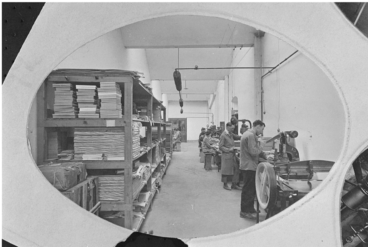
Vue ancienne de l'atelier de gainerie.
