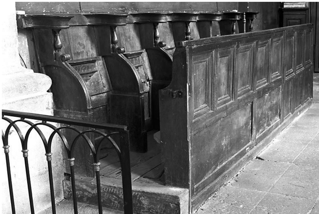
Vue d'ensemble du côté nord. 25, Lods
