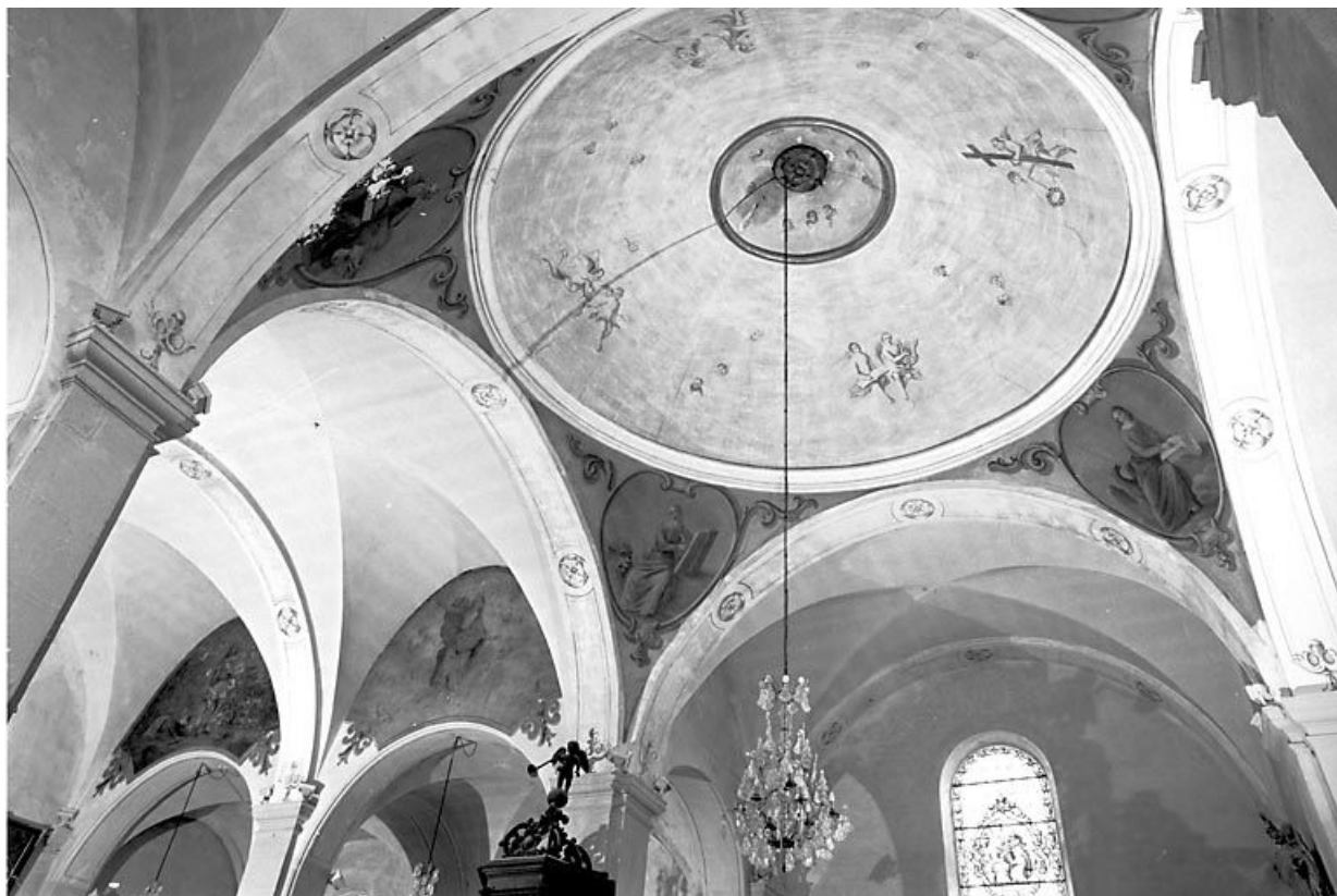
Vue d'ensemble. 25, Lods
