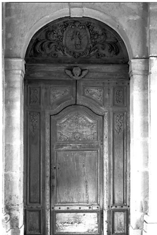
Vue de face avec la porte d'entrée de la tour-clocher. 25, Goux-les-Usiers
